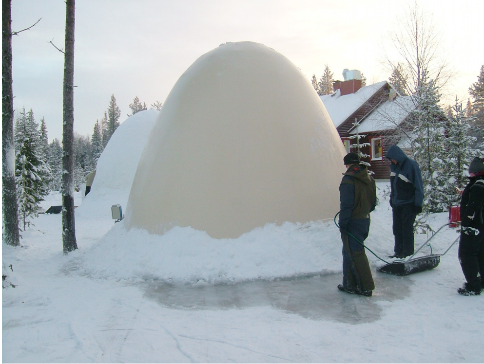
Kuva 8. Ketjukäyrän muotoinen ilmanpainemuotti 42
