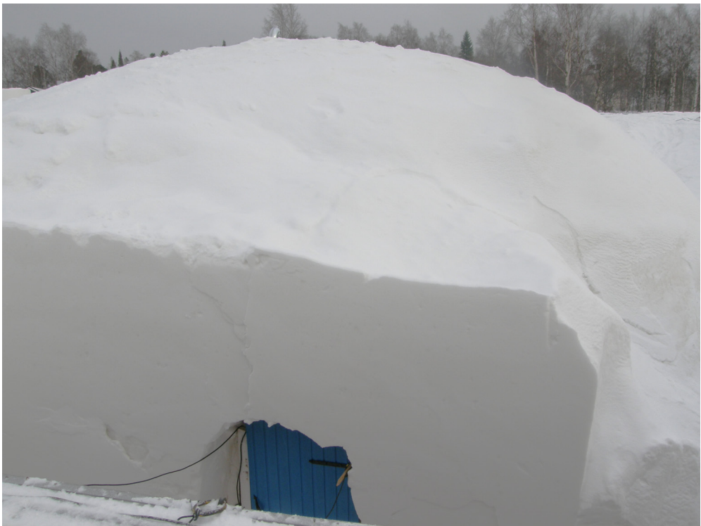
Kuva 12. Ellipsin muotoinen rakenne Kemin lumilinna 2009 49
