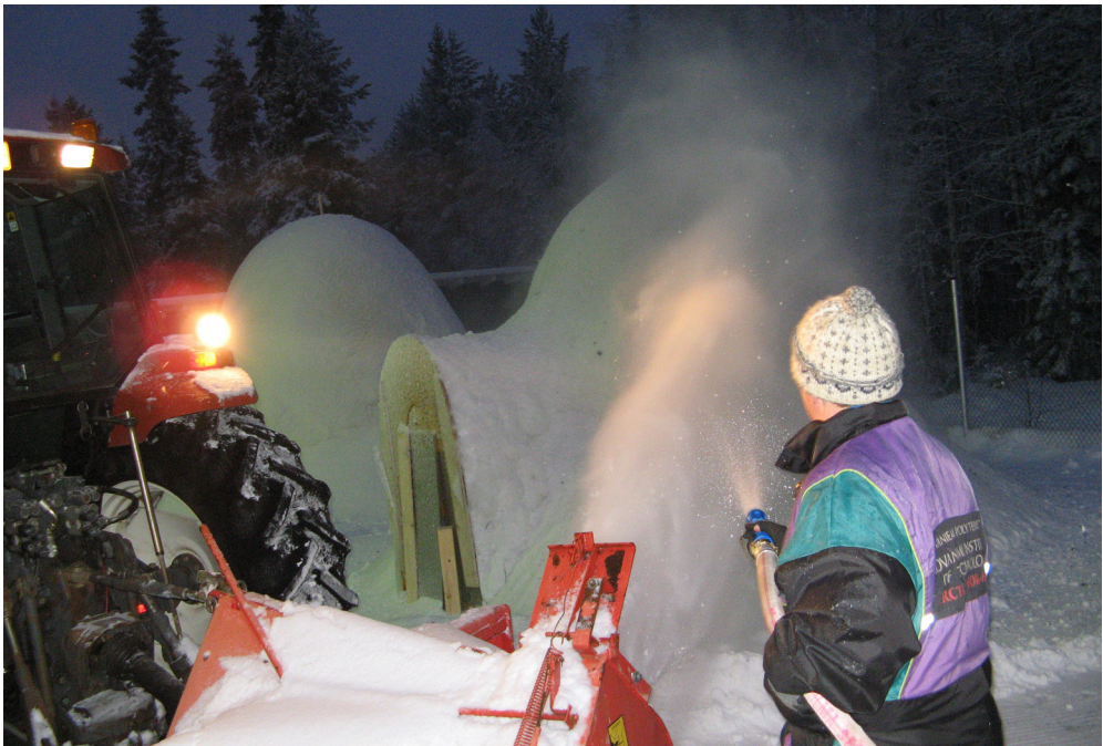
Kuva 21. Veden sumutus lumetusvaiheessa 73
