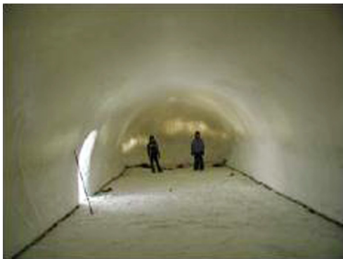
Kuva 26. Muovimuotilla tehty lumigalleria 83
