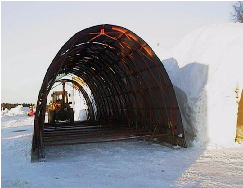
Kuva 7. Ketjukäyrän muotoinen teräksinen holvikaarimuotti 41
