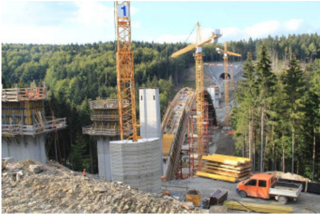
Höchster Punkt der Strecke mit 603 Metern im Mittelgebirge Thüringer Wald, Standort DB-Aussichtsplattform, Blick auf die Dunkelthalbrücke mit anschließendem Tunnel Fleckberg. Foto: DB AG / Frank Kniestedt.
