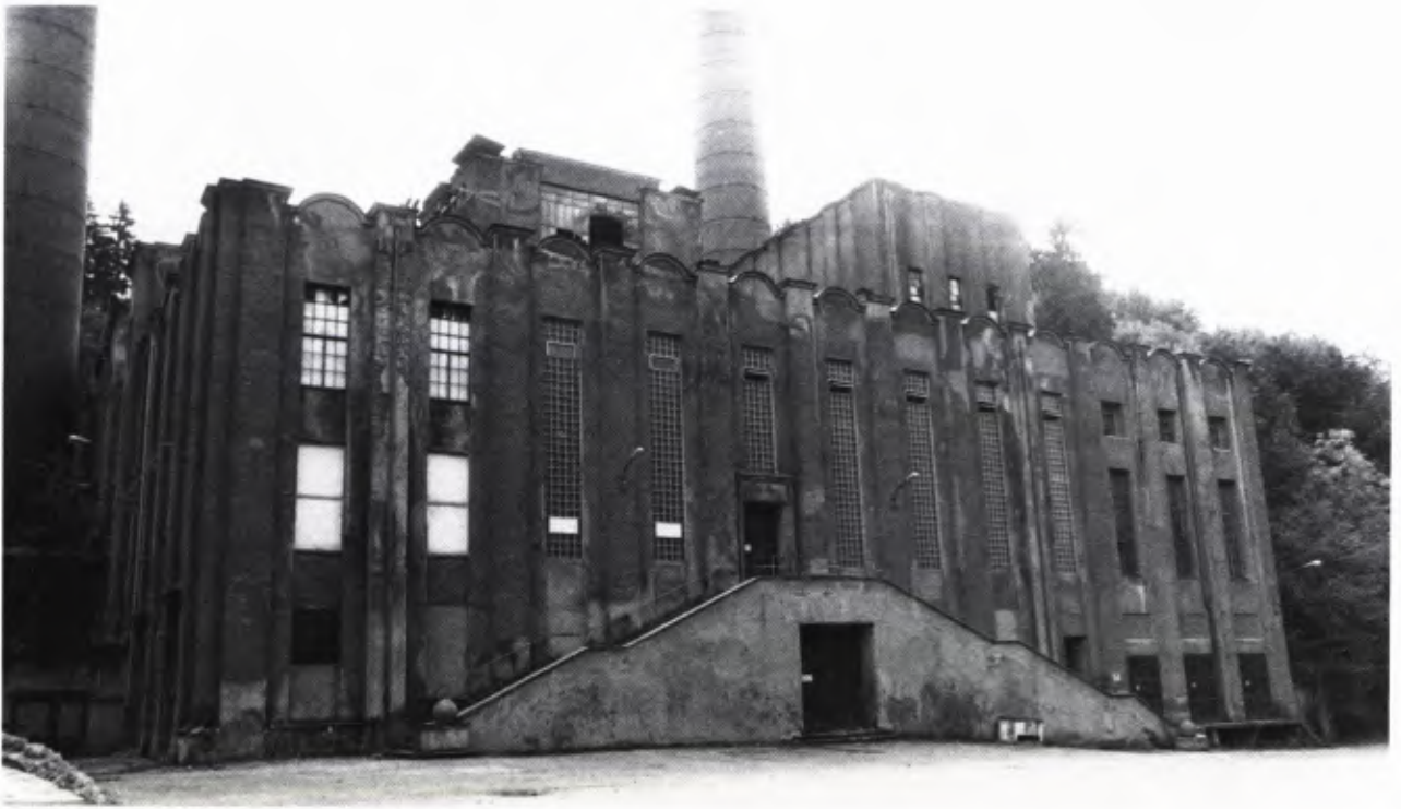
12 KRAFTWERK, Hauptfassade, Neckartal 68.
