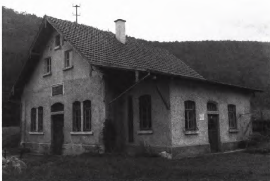
10 DAS PUMPWERK in Schelklingen-Teuringshofen. Errichtet als erstes Pumpwerk der Albwasserversorgung nach Plänen von Karl Ehmann 1870.
