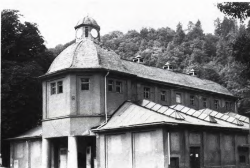
13 WASCH- UND UMKLEIDEGEBÄUDE für Arbeiter, Neckartal 142.
