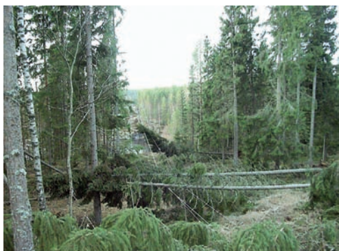
Høland og Setskog Elverk har store deler av sitt forsyningsnett gjennom skogområder. Linjene er spesielt utsatt i forbindelse med sterk vind og snøbelastning.
