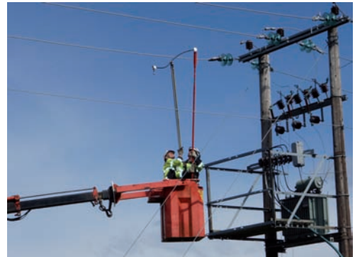
Idar Sørli og Jan Egil Viken utfører arbeid under spenning (AUS) i forbindelse med høyspentarbeid. Det er en praktisk metode for å slippe utkobling mens arbeidet pågår. Høland og Setskog Elverk har flere ansatte med spesialkompetanse til å utføre denne type arbeid. Foto: Birger Slupstad.
