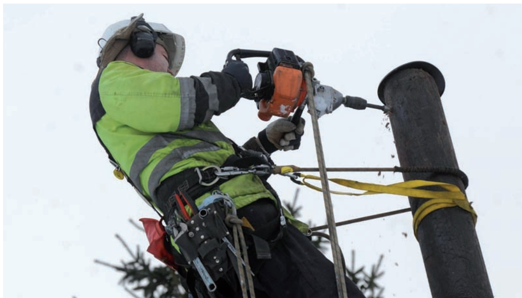
Jan Egil Viken forbereder montasje av utstyr i mast.
