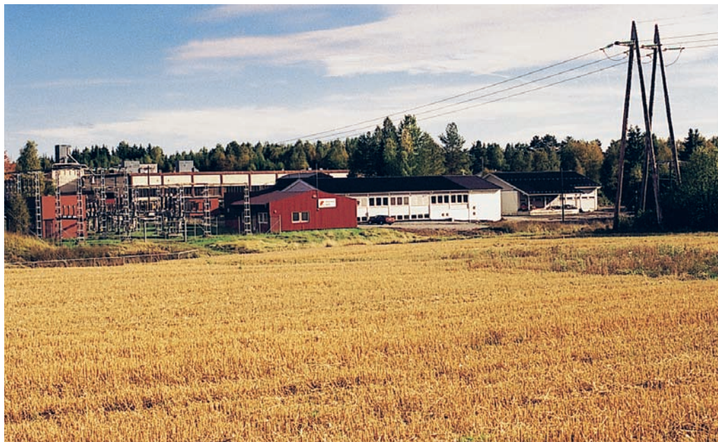
Høland og Setskog Elverks lager og kontor etter den siste utbyggingen på Prestegårdshagen. (Foto: Per Erik Nilssen)
