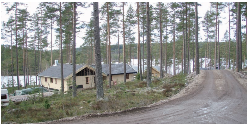
Hyttefeltet ved Vortungen i Rømskog forsynes med kraft fra linjenett fremført av Høland og Setskog Elverk bestilt av Fortum Distribution AS.
