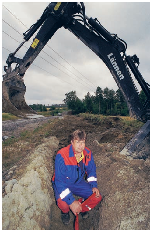
Magne Malnes sørger for at elektriske kabler kommer til jords og at de blir godt tildekket igjen. (Foto: Per Erik Nilssen)
