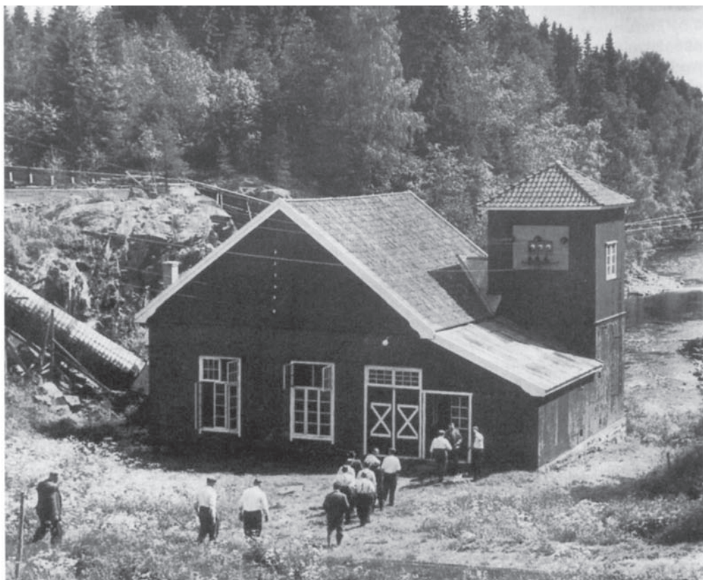
Lunds foss kraftstasjon var den første strømleverandøren til Høland Elektrisitetsverk.
