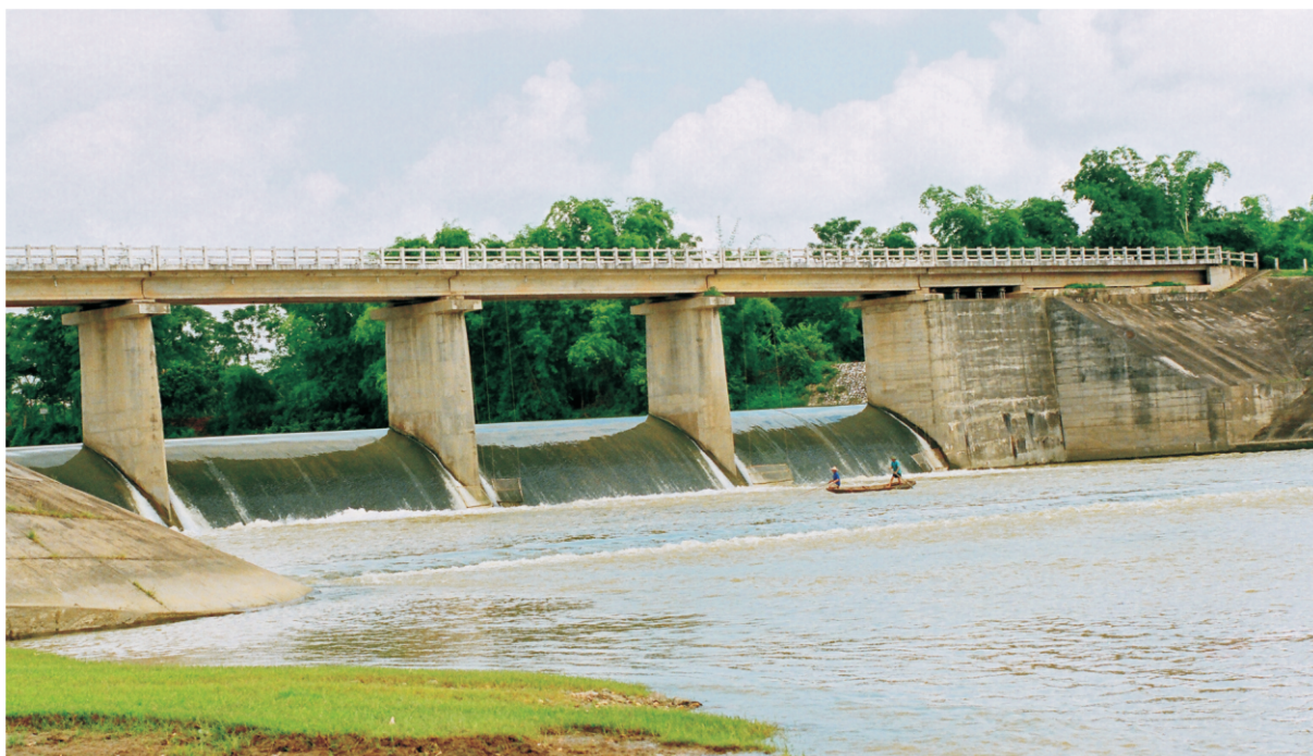
Đập Thác Huống
