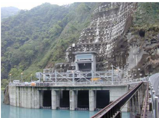
照片 1 新武界進水口完成
