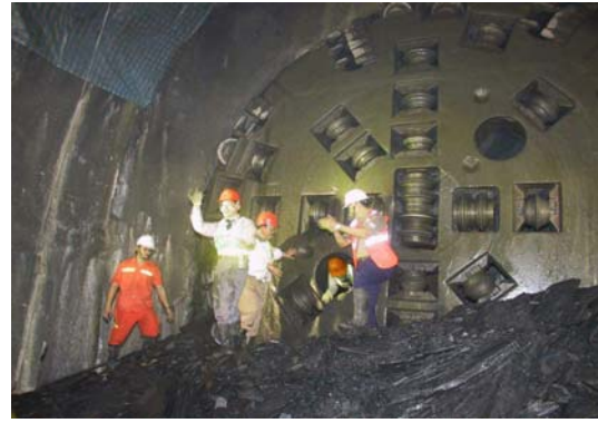
照片 4 隧道貫通後工作人員從 TBM 人孔步出
