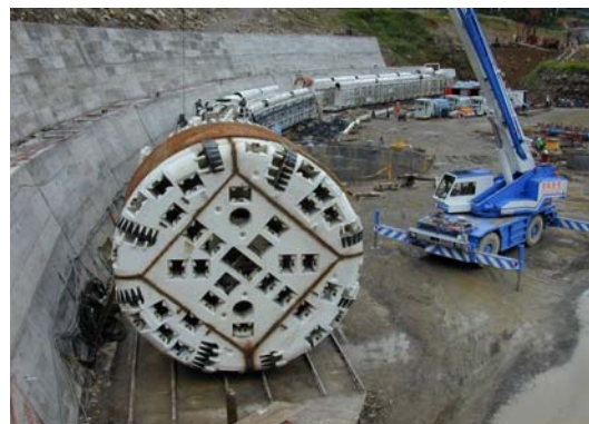
照片 2 TBM 組裝
