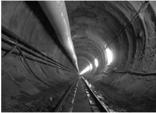
照片 3 TBM 開挖完成
