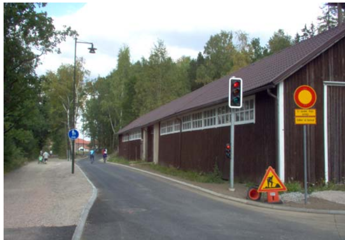
Kuva 44. Vantaan Tammistontien ja Tilkuntien joukkoliikennekatu yhdistää Tammiston ja Pakkalan alueet. Katuosuus on yksiajoratainen ja noin 150 metriä pitkä. Osuuden toiseen päähän ei ole näköyhteyttä. Sen vuoksi liikennettä ohjataan valo-ohjauksisesti.
