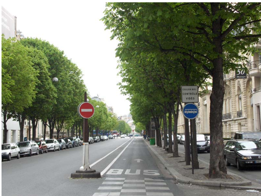
Kuva 10. Vastavirtakaista Pariisin Avenue Montaignella. Opastemerkillä kerrotaan, että kaistan väärinkäyttöä valvotaan videovalvonnalla.
