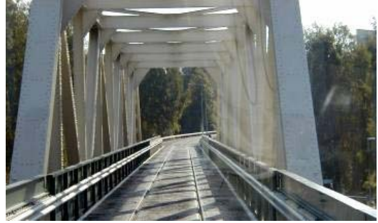
Kuva 43. Maaherrantien joukkoliikennekadulla on kaksi yksikaistaista siltaa, joita ohjataan valo-ohjauksisesti (Sane 2005).
