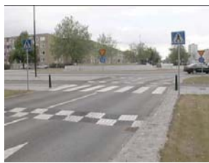
Kuva 52. Kumpu suo- jatien yhteydessä eli korotettu suojatie (Shercom Industries Inc. 2006).
