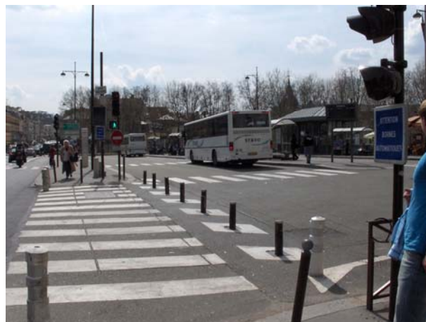
Kuva 47. Ajoesteet estävät pääsyn terminaali-alueelle. Bussin saapuessa esteet laskeutuvat maahan. Esteet on toteutettu Versailles – Rive Gauche -aseman bussiterminaalissa Ranskassa.
