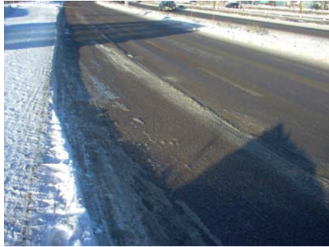
Kuva 54. Länsiväylällä Hanasaaren pysäkillä on ajouran kohdalla jäätä ja reunakiveyksen vieressä paksua lumikerrosta. Kuva on maanantailta 22.1.2007, kaksi päivää lumisateen jälkeen.
