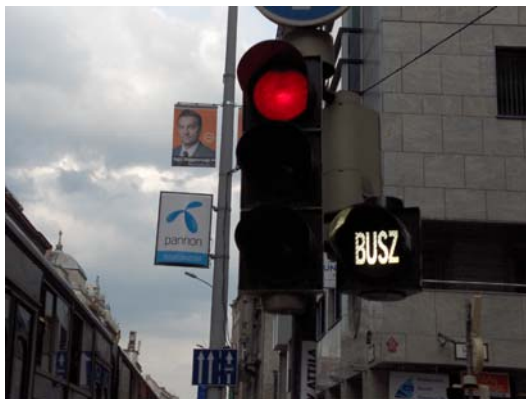
Kuva 32. Ennakkovalot suojatievalojen yhteydessä Kossuth Lajos Utcalla Budapestissä.
