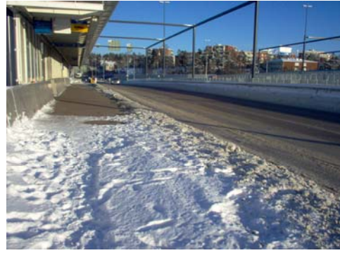
Kuva 55. Jokeri-linjan (linja 550) pysäkki Leppävaarassa Kehä I:llä Espoossa. Kuva on maanantailta 22.1.2007, kaksi päivää lumisateen jälkeen. Katoksen alainen osuus on puhtaana grafiittiasfaltin ansiosta (YTV 2007b, kuva Simo Airaksinen).
