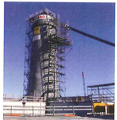
6000 t schwere Anlagen dieser Bauweise übernimmt der Halbtaucher von einer Fingerpier
