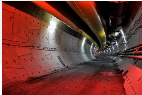
Tunnel du Fréjus France-Italie – Razel-Bec
