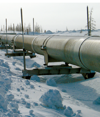
Нефтепровод Ванкор-Пурпе. Индивидуальные термостабилизаторы, установленные совместно со сваями
