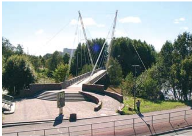
Kuva 2. Heureka-kävelysilta Keravajoen yli. Siltaan on maalattu rakenteen värähtelyä monitoroiva pietsomaalianturi.
