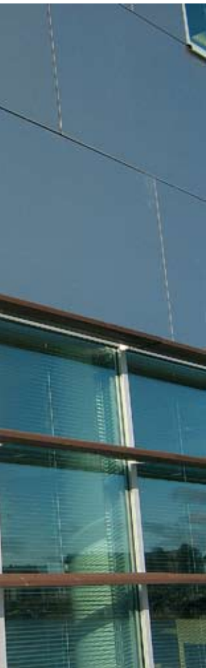
Kuva 1. Ruostumattomasta teräksestä valmistetuista rakennusverhoilu-elementeistä valmistettu seinäpinta.
