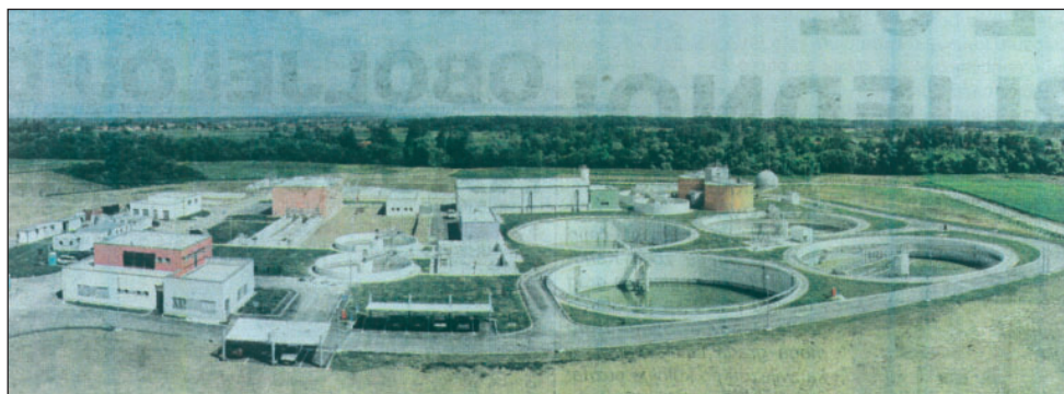
Pročišćivač otpadnih voda
