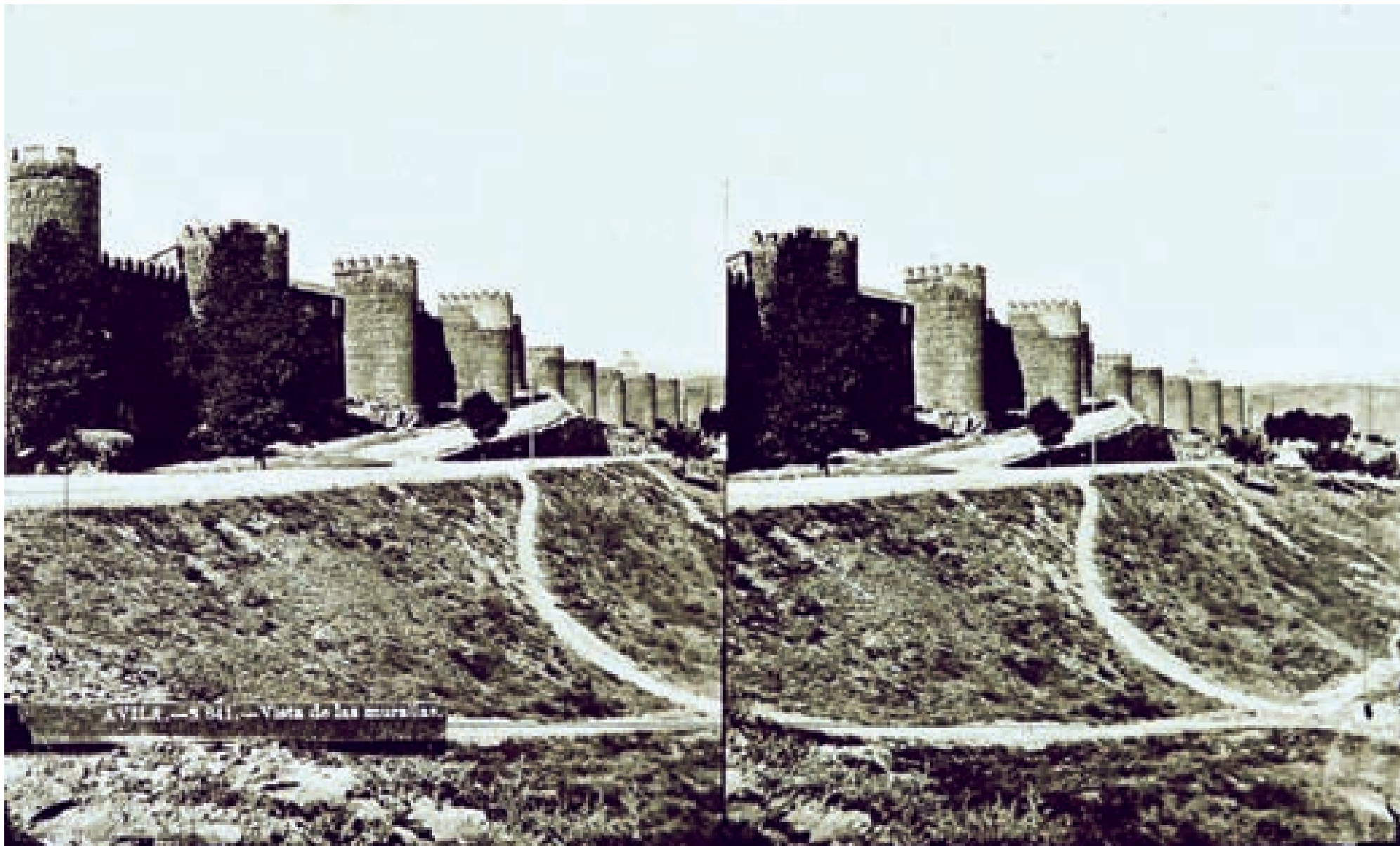
AVILA. Vista de las murallas.
