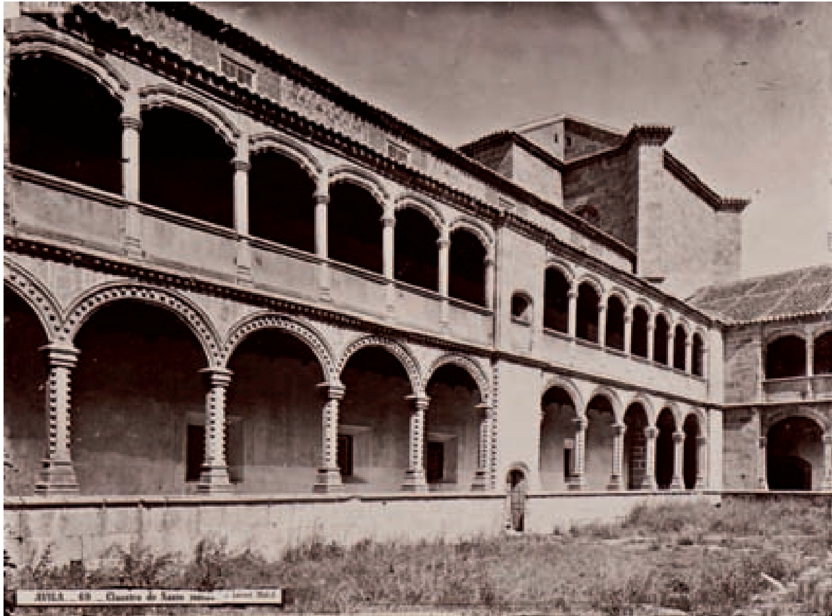
ÁVILA. Claustro de los Reyes del Convento de Santo Tomás.
