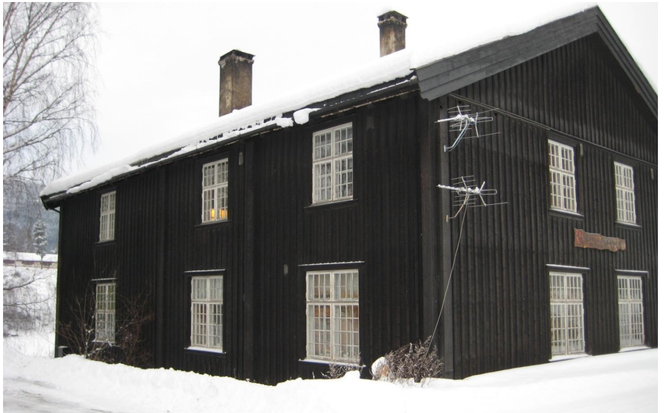
Figur 17: Gammelbanken. Tatt mot NV.
