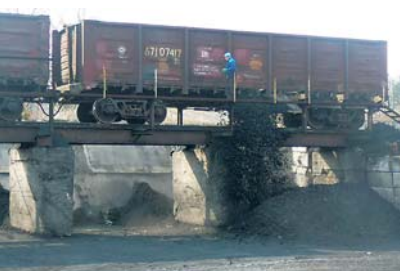
Разгрузка угля с железнодорожных вагонов на эстакаде склада ООО «Витринит-1» в п. Черниговка
