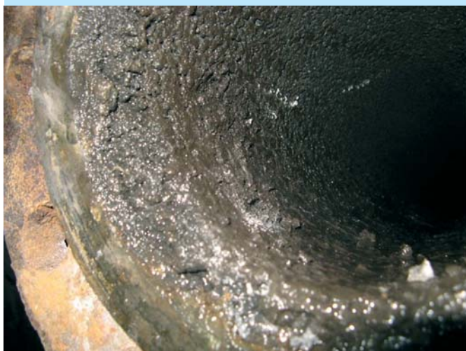
3. Участок очищаемого трубопровода. В верхнем своде трубы отчетливо видны структурные изменения поверхностного слоя отложений (как «губка») по состоянию на 2 августа 2007 г.
