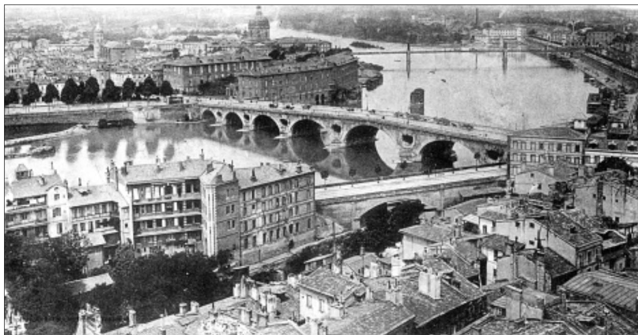
FIG. 1. TOULOUSE. LE PONT NEUF DANS SON SITE. Vue aérienne montrant le pont neuf, les vestiges de l'ancien pont couvert de La Daurade, et le faubourg Saint Cyprien, avec à droite les bâtiments de l'Hôpital Saint-Jacques et à gauche le quai Saint-cyprien, ou quai des Ormes, actuellement Cours Dillon.
