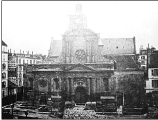
FIG. 17. PARIS. ÉGLISE SAINT-LAURENT. L'ancienne façade en cours de démolition (vers 1862).
