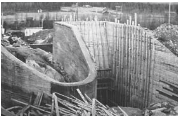
Patokaarre koneaseman luona. Tulva-aukon rakennus. Vuosi 1956.
