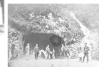
明治10年 工事中の栗子トンネル
