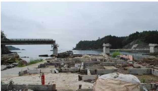
住居区基礎のみ残る歌津地区
