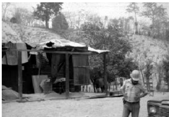
Fig. 28. En regiones más cercanas al centro eruptivo, aparte de la ceniza volcánica, los fragmentos de mayor tamaño pueden producir perforaciones y severos daños a los techos, y a las vías de comunicación. Estas fotos muestran ese tipo de daños producidos por las erupciones del volcán El Chichón en 1982, dentro de un radio de 10 km. Arriba, foto de un techo perforado por líticos. A la derecha un puente semidestruído por impactos de líticos. Fotos de S. De la Cruz.
