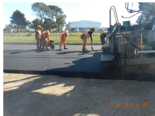
Ilustración 7: Frente de obra con la construcción de pavimento con mezcla asfáltica
