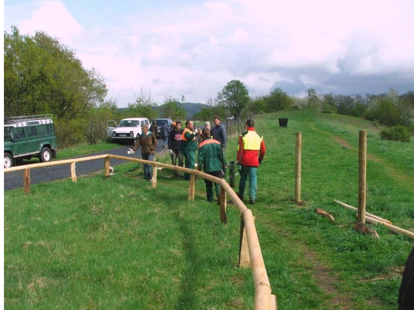
Bau des Zauns und neue Geländer am Rodderbera. 5.4.2011.
