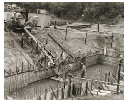
Fundamentene til slusen og pumpehuset ude ved Egåens udløb blev støbt under vanskelige vilkår, da entreprenøren måtte arbejde i flydesand. Byggegruben blev holdt tør ved hjælp af en række lodrette borer i skråningssiderne, hvorfra vandet kunne ledes bort. Slusen og pumpehuset blev bygget helt ude ved stranden. De ligger der stadig og er i fuld funktion. Foto: Hedeselskabet.
