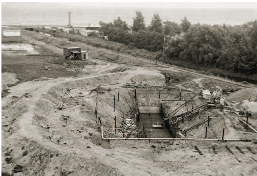
Fundamentene til slusen og pumpehuset ude ved Egåens udløb blev støbt under vanskelige vilkår, da entreprenøren måtte arbejde i flydesand. Byggegruben blev holdt tør ved hjælp af en række lodrette borer i skråningssiderne, hvorfra vandet kunne ledes bort. Slusen og pumpehuset blev bygget helt ude ved stranden. De ligger der stadig og er i fuld funktion. Foto: Hedeselskabet.
