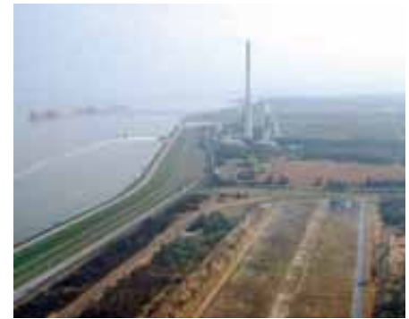
Auf diesem Gelände wird der JWP entstehen
