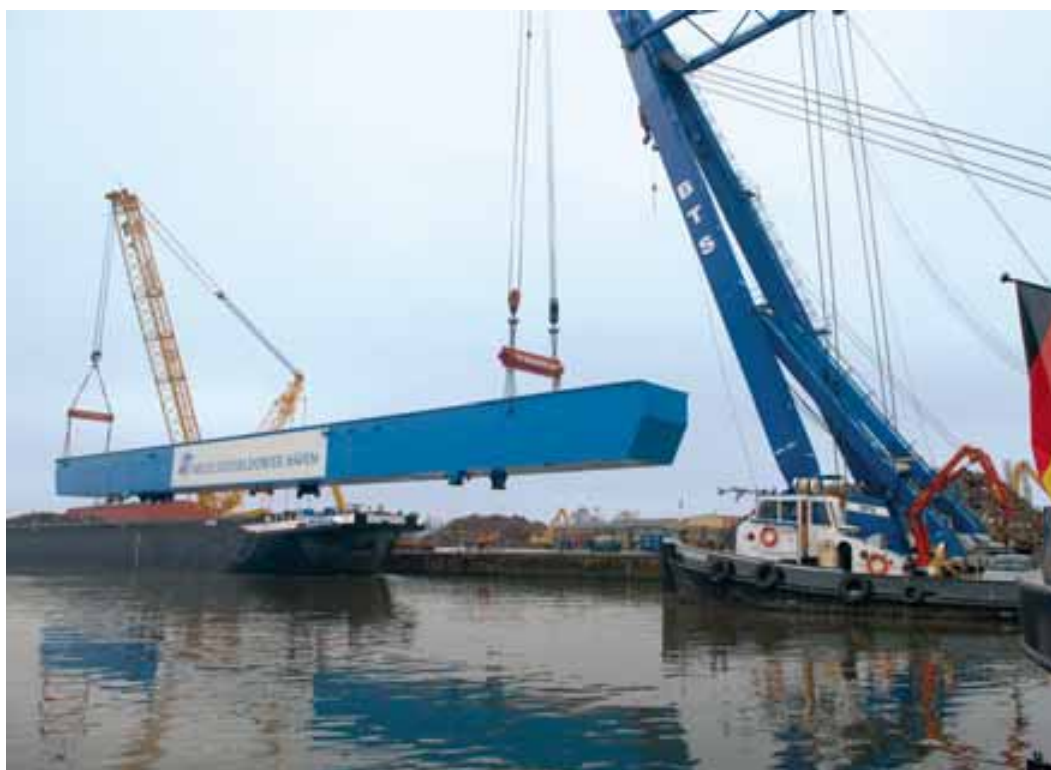
Die Verladung der 88 Meter langen und 240 Tonnen schweren Kranbrücke stellte höchste Anforderungen an die Logistik – ein 300-Tonnen-Schwimmkran sowie mehrere Mobilkrane kamen zum Einsatz
