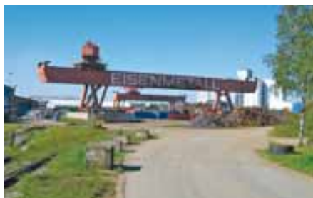
Die beiden 30 Jahre alten Portalkrane vor der Umsetzung in Mülheim an der Ruhr
