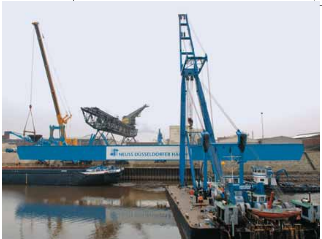
Die Entladung am neuen Standort im Hafen Neuss-Düsseldorf wurde in einem sehr engen Zeitfenster bei zum Teil widrigen Wetterverhältnissen realisiert
