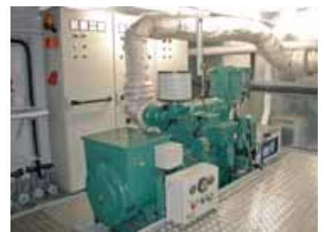
2 VOLVO PENTA Dieselaggregate D 5 A/TA bringen mit einer Leistung von je 95 KVA die notwendige elektrische Energie an Bord
