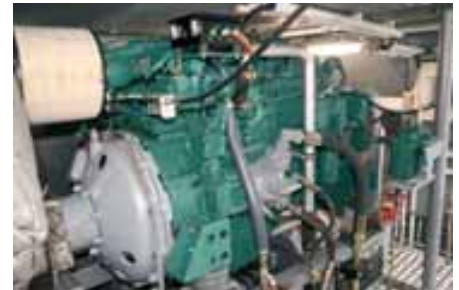
6Zylinder-Herz: Ein Volvo D7CTA mit 182 kW im Bauch der „Inselstadt Ratzeburg“ sorgt für kraftvollen Vortrieb Bild: Mainzer
