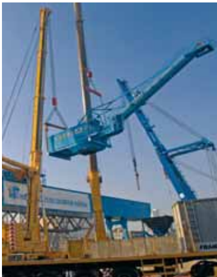
Der Drehkran wird in die richtige Position manövriert
