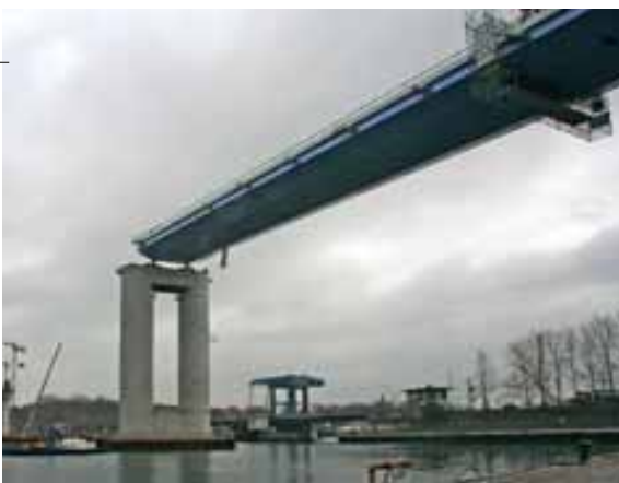
Auflage des längsten und schwersten Teilstücks der Rügenbrücke Bild: Teßmann
