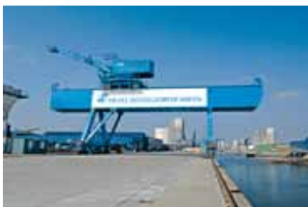
Die komplett modernisierten Krane können ihre Arbeit am neuen Standort aufnehmen
