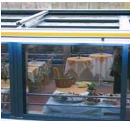
Zu 2/3 lassen sich die Dach- und Seitenfensterelemente der 12m langen Glasfront öffnen
