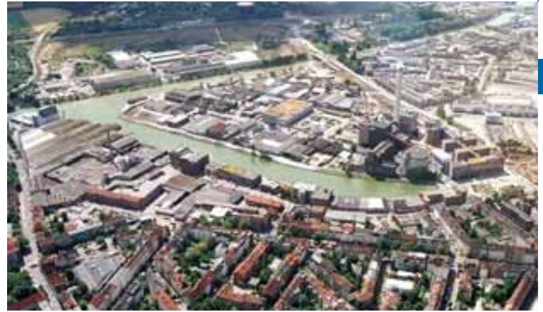
Ein neues Gas- und Dampfturbinenkraftwerk im Stadthafen Münster wächst heran und wird künftig Strom aus Kraft-Wärme-Kopplung statt Kohle erzeugen. Im Jahr 2006 wird der Umschlag um 150.000 t reduziert, da die Kohlelieferungen wegfallen
