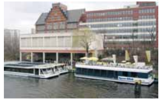
Die Anlegestelle der Reederei Riedel an der Hansabrücke in Berlin erstrahlt in neuem Glanz, vor Ort liegen das fest verankerte Café-Schiff Spree-Blick (rechts) und die beiden neuen Fahrgastschiffe Spreeblick 1 und 2 Bilder: Ricken
