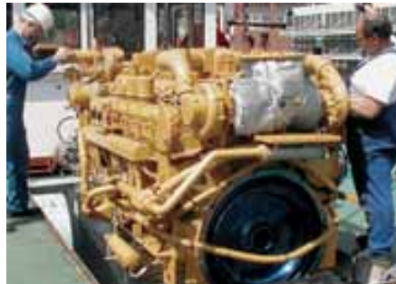
Mit einem Mobilkran wurden Getriebe und der Caterpillarmotor eingekrant Bild: Hitzler
