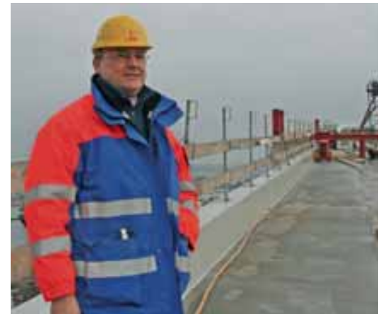
Udo Hiller, Montageleiter der Rügenbrücke/Fa. Max Bögl Bild: Teßmann
