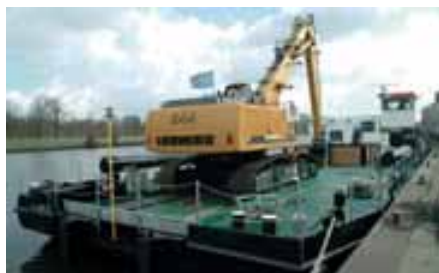
Ein LIEBHERR 944 Bagger mit langem Ausleger und verschiedenen Anbaugeräten, die über Schnellverschlüsse zu montieren sind, sorgt für hohe Leistungsparameter des Gesamtgerätes
