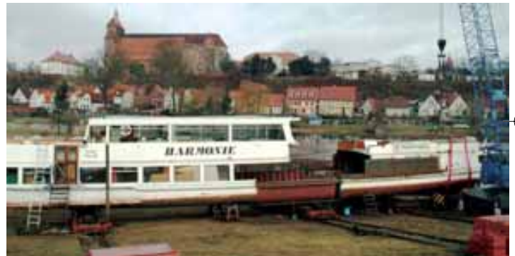
Das Fahrgastschiff „Harmonie“ der Reederei Herzog wurde auf der Kiebitzbergwerft um 3,5 m verlängert Bild: Tausche
