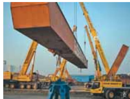
Die 88 m lange und 240 t schwere Kranbrücke wird demontiert Alle Bilder: KSR
