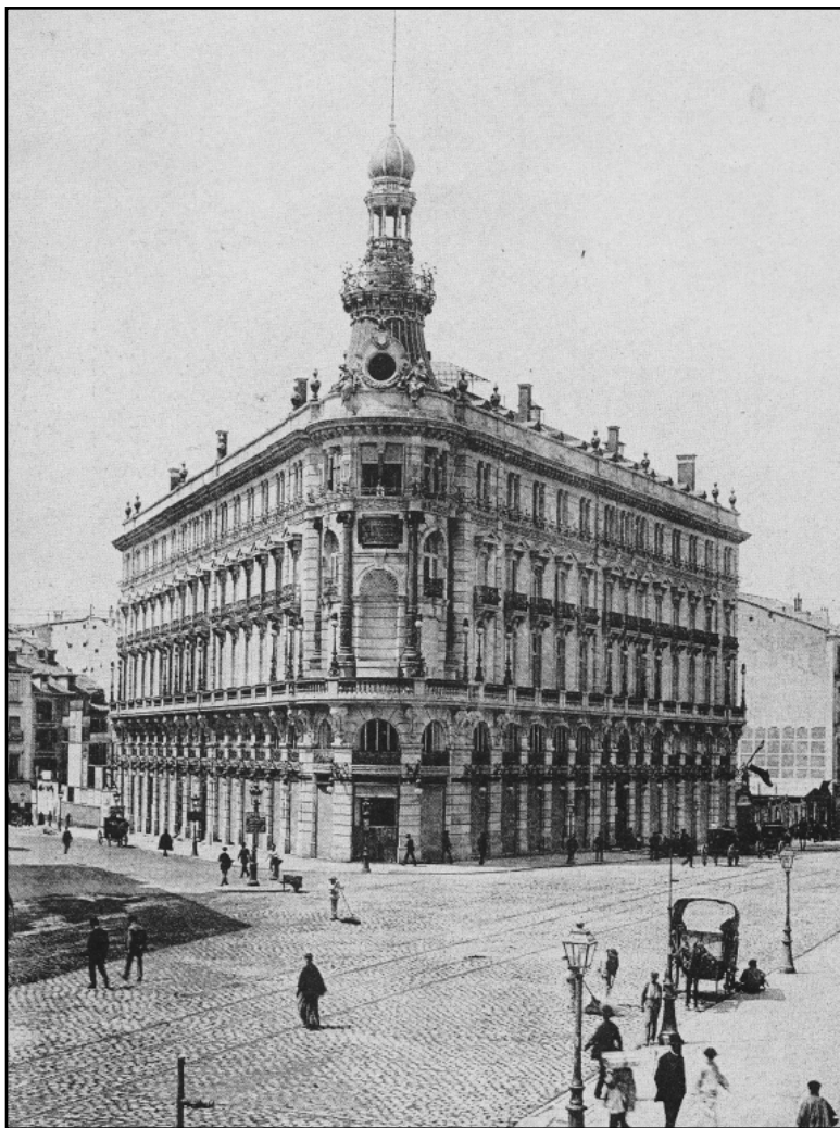
Lámina 1. Edificio de La Equitativa . Grases Riera (1887-1891).
