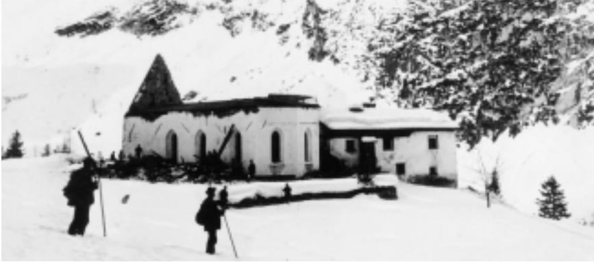
Die Kirche von St. Magdalena wurde im Februar 1888 durch eine Windlawine stark beschädigt.
