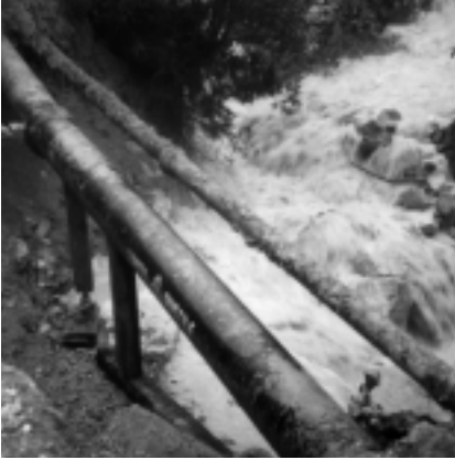
Die freigelegte Trinkwasserleitung der Gemeinde Absam bei der Kitzzweng im Juli 1987.
