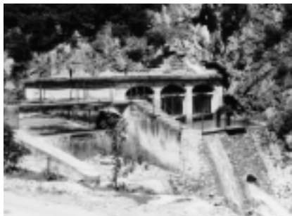
Das 1913 in Betrieb genommene Einlaufbauwerk des Halltalkraftwerkes der Stdt Hall (Aufnahme Juli 1933).
