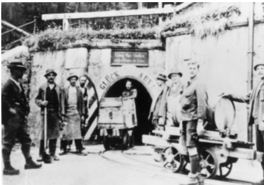
Grubenhunt mit Solefaß vor dem König Max Stollen. Aufnahme kurz vor dem 2. Weltkrieg. Die Sole wurde zum Kochen im Herrenhaus verwendet. Foto: AF III / 43
