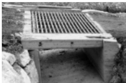
Die 1994 neu errichtete Eibentalbrücke
