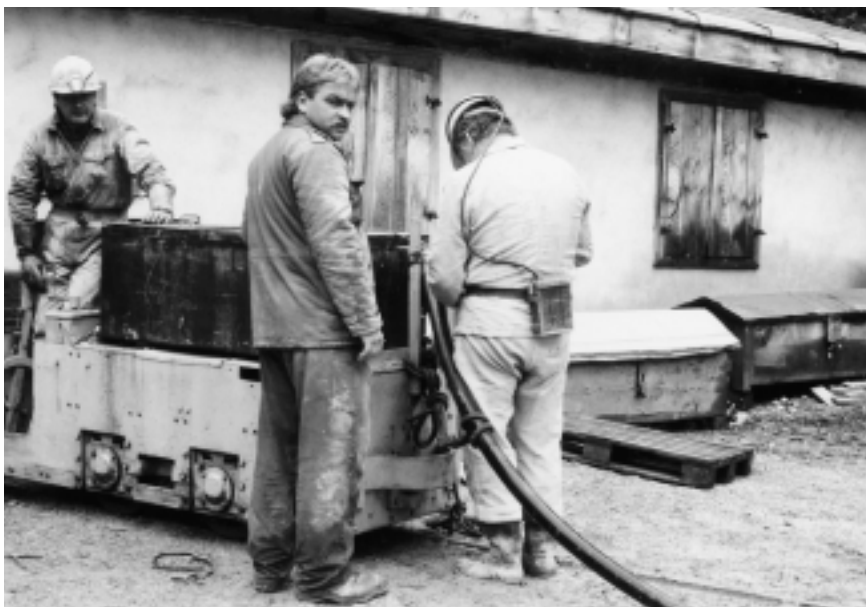
Sanierungsarbeiten am Haller Salzberg durch die VA-Erzberg 1992
