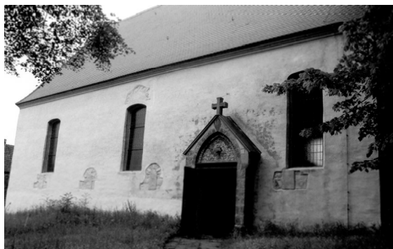
Abb. 217, Nordwand des Kirchenschiffes
