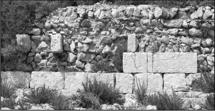
Resim 9: Adanın kuzeydođu köşesindeki bir yapıda görölen düzgün kesme taş kaplama duvar
