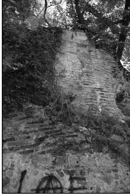
Resim 3: Baltalimanı, duvar kalıntıları
