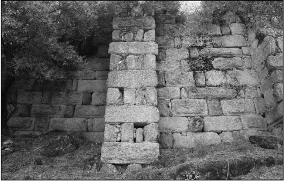
Abb.3: Die in der Kaiserzeit wieder instandgesetzte nördliche Befestigungsmauer der Unterstadt mit talseitig vorgeblendeten Pilastern (Photo: J. Köck, ÖAW Inv. Nr. Alinda 2010_IMG_2416_01).
