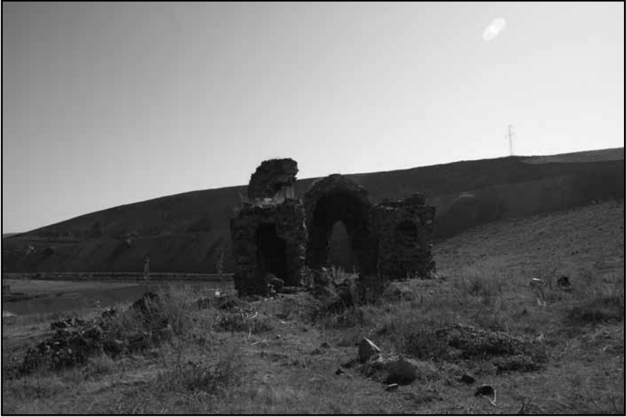
Resim 9: Mezraa Köyü Kilisesi-batı cephe
