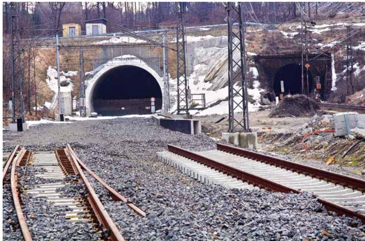
U PORTÁLŮ. Vlevo vidíte problémovou stavbu nového tunelu, vpravo jednokolejný tunel sloužící od roku 1870. FOTO AUTOR
