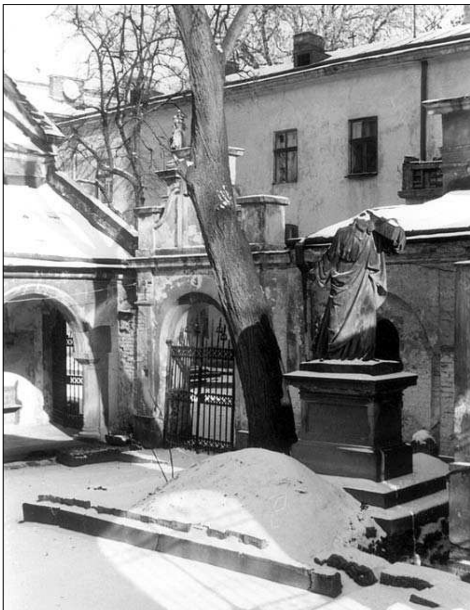
[Il.12] Figura Chrystusa niosącego krzyż, autorstwa Tomasza Dykasa z 1889 r., ustawiona na dziedzińcu południowym. Fot. J. Chrzęszczewski, 1994.
