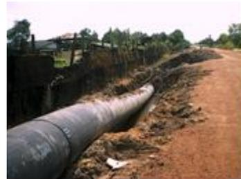
*Pemasangan Pipa Transmisi Ø=800 mm*
