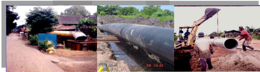
*Pemasangan Pipa Transmisi Air Baku  $\varnothing$ 1.000 mm, Pipa  $\varnothing$  800 mm dan  $\varnothing$  630 mm*
