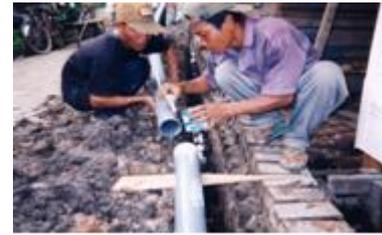
*Pekerjaan Perbaikan Pipa Bocor*
