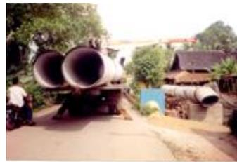
*Pemasangan Pipa Transmisi Ø=1.000 mm Pekerjaan Jembatan Pipa Ø=1.000 mm*
