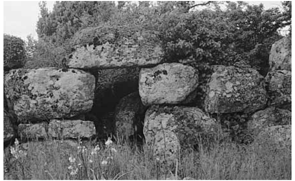
Fig. 681. Bolotana, Nuraghe S'Ena Ettrosa: particolare dell'ingresso.
