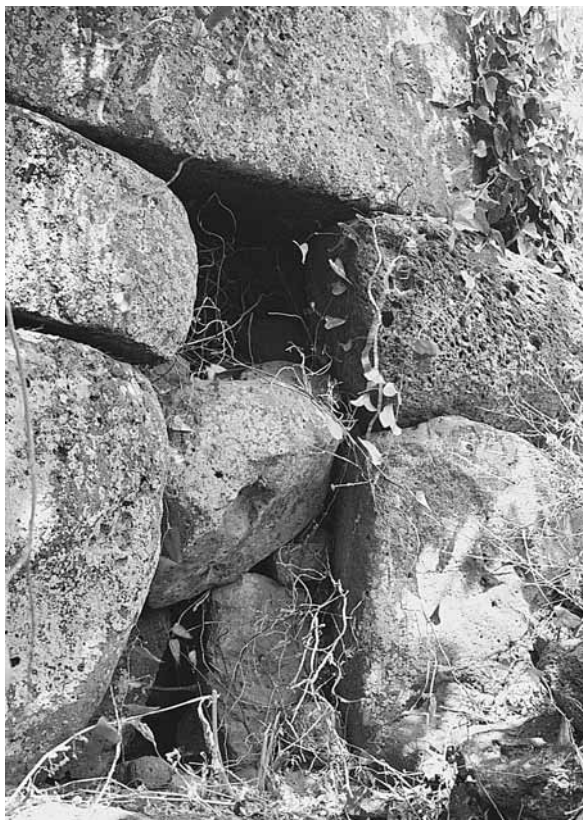
Fig. 441. Birori, Nuraghe Puttusuiile A: particolare dell'ingresso.
