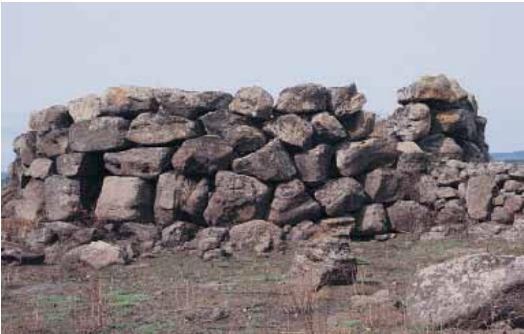
Fig. 657. Borore, Nuraghe Sas Casas: veduta da SE.
