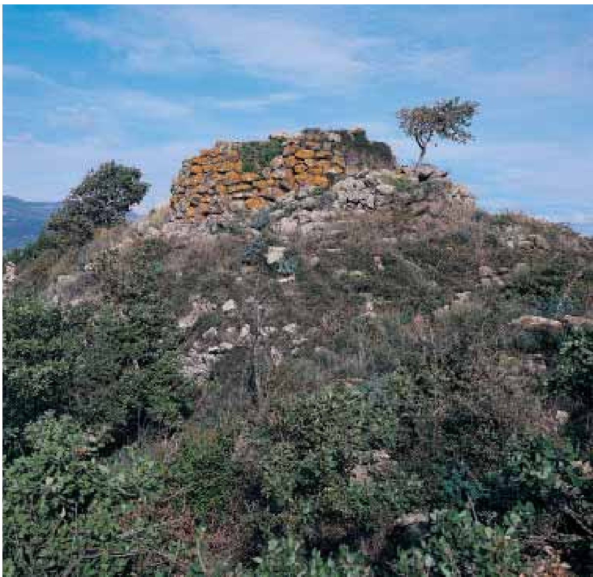
Fig. 470. Birori, Protonuraghe S'Iskra de s'Abbasanta: veduta da SE.
