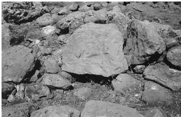
Fig. 430. Birori, Nuraghe Miuddu: ingresso interrato della struttura (protonuraghe ?) messa in luce a Est del nuraghe.
