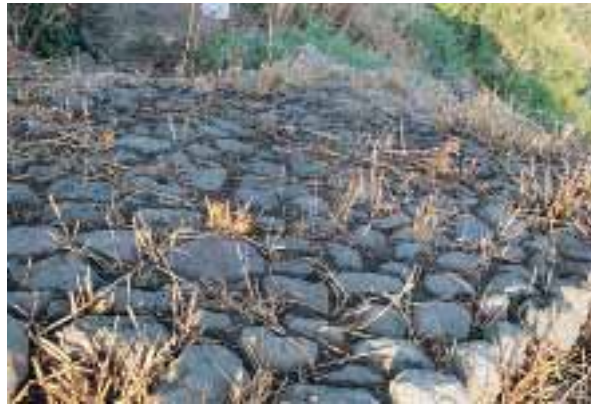
Fig. 279. Macomer, Protonuraghe Mene: particolare della copertura a doppio tetto spiovente
