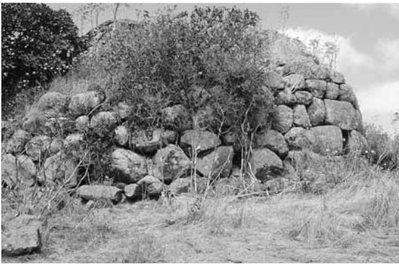
Fig. 72. Macomer, Nuraghe Porru: lato SSE.
