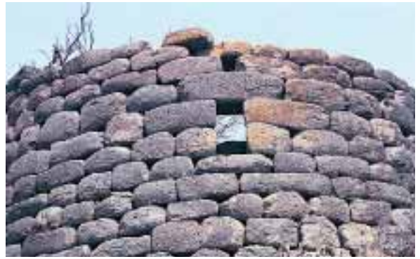
Fig. 925. Dualchi, Nuraghe Ponte: particolare della muratura all'altezza del finestrone del primo piano.
