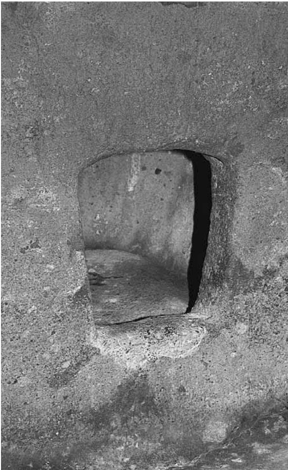
Fig. 349. Bortigali, Domu I Orolo: portello che introduce nella cella B/C.
