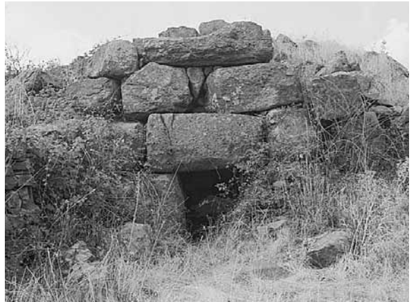
Fig. 671. Bolotana, Nuraghe Sos Compensos: particolare dell'ingresso.
