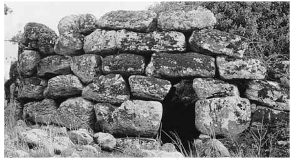
Fig. 16. Macomer, Nuraghe Mura Ine: particolare dell'ingresso.
