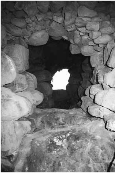
Fig. 280. Macomer, Protonuraghe Mene: corridoio con ingresso Est.
