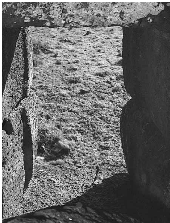
Fig. 927. Dualchi, Nuraghe Ponte: particolare del finestrone del primo piano, visto dall'interno, con riseghe laterali per l'incastro del portello di chiusura.
