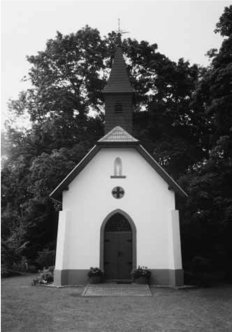
Abb. 22: Die „Geistkircher Kapelle“ im neuen Glanz: Das Dach ist neu eingedeckt, die Kirche frisch gestrichen – wie immer durch Helmut Staut. Ebenso sind die Außenanlagen bereits wieder hergestellt (Fotosammlung: Klothilde Haselmaier).
