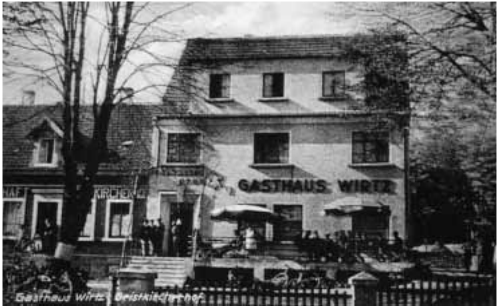
Abb. 10: Das Gasthaus „Wirtz-Geistkircherhof“. Der linke niedrige Bau entspricht dem Gasthaus von 1893; der rechte höhere Bau ist das Ergebnis der Modernisierungsmaßnahme in den Jahren 1934/35 (Fotosammlung: Dieter Wirth).
