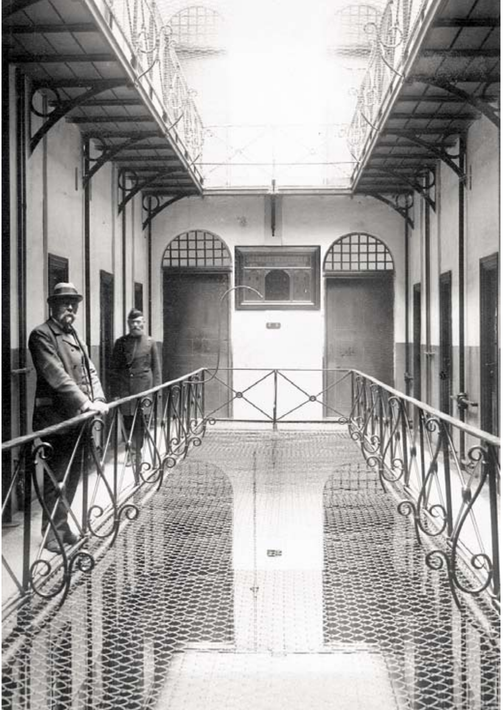
Midterfløjen kaldet Gammel Celle var indrettet efter det panoptiske princip. Et lille antal vagter kunne her overskue et stort område.
