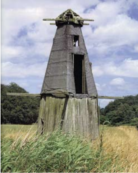
Fra Vejle Amts bog om Kulturhistoriske beskyttelsesområder 1998: Rester af gl. pumpemølle der afvandede strandenge ved Damgård, sydøst for Taulov.
