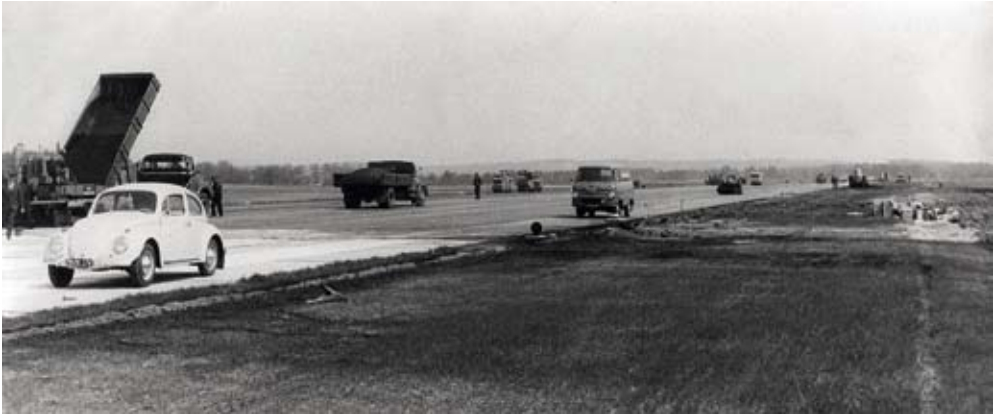
I efteråret 1964 arbejdedes der på bøjtryk for at få alt på plads til åbningen i november. Her er det arbejdet med startbanen. Foto: Billund Lufthavn.
