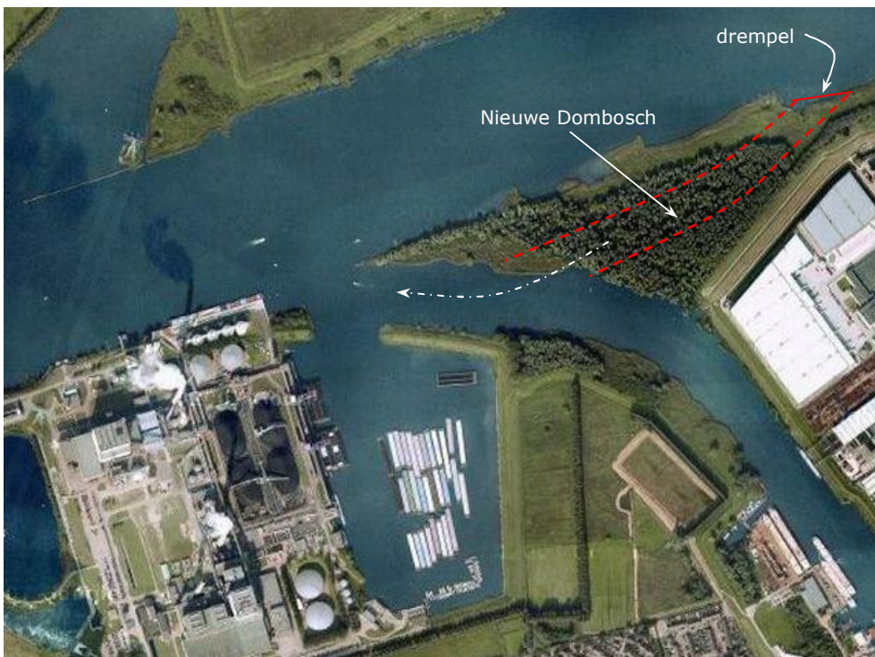
Figuur 4-6 Aanleg nevengeul
