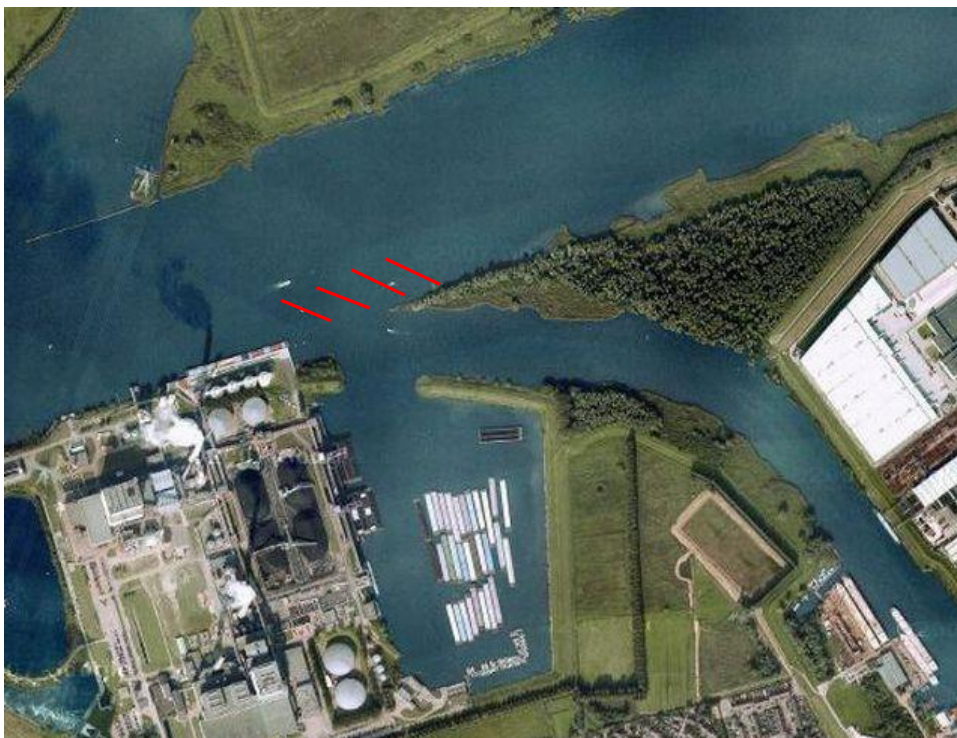
Figuur 4-7 Aanleg zandspiraalbuizen
