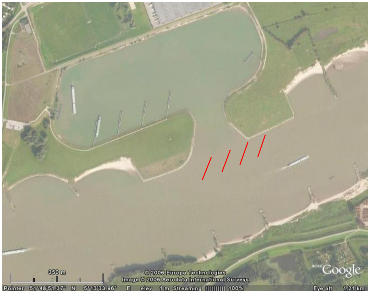
Figuur 4-13 Aanleg zandspiraalbuizen voor de overnachtingshaven Haaften
