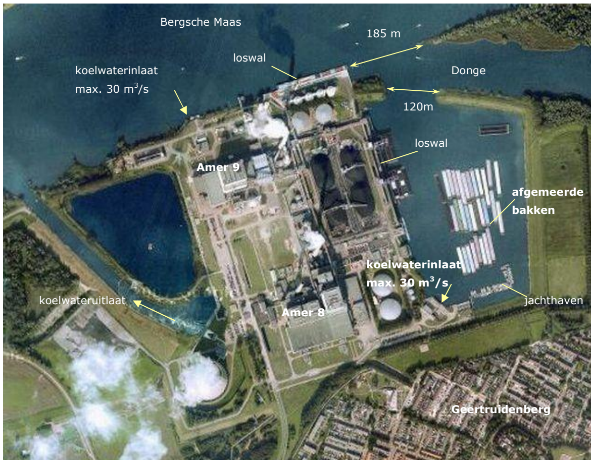
Figuur A-1 Overzicht industriehaven bij Amercentrale met koelwaterinlaten en -uitlaat
