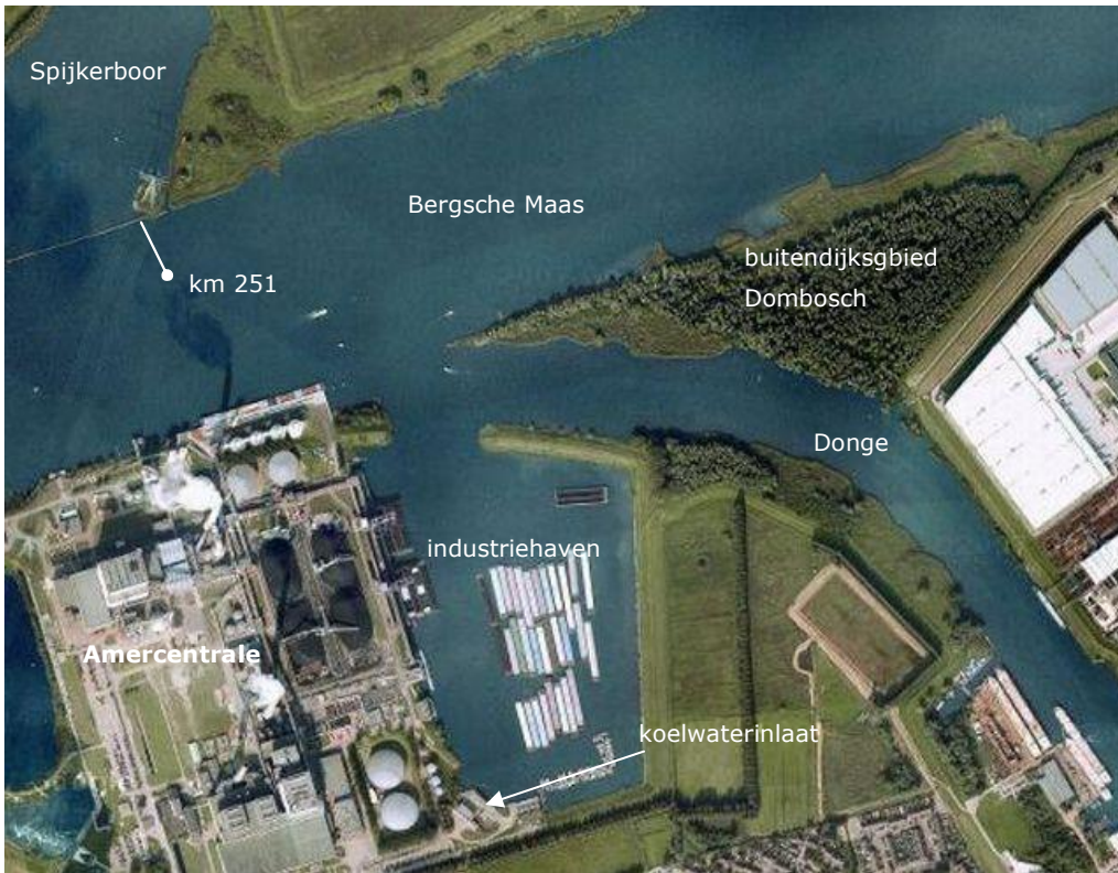
Figuur 2-1 Industriehaven Amercentrale langs de Bergsche Maas nabij km 251
