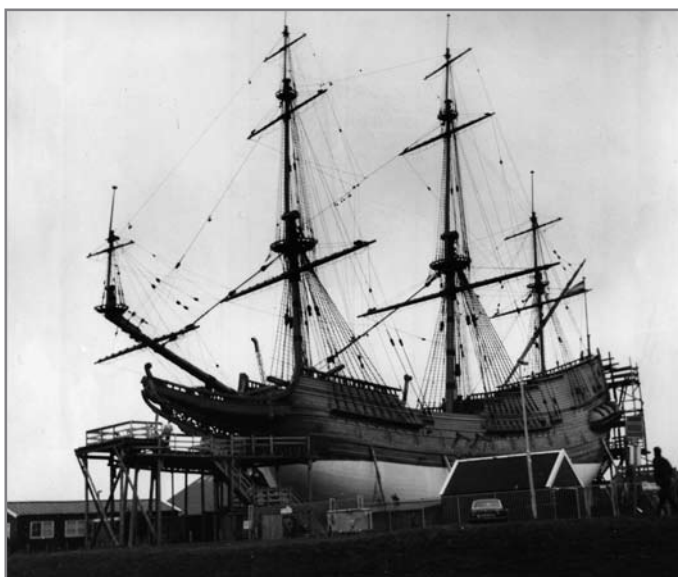
Верфь в Лелейстаде. Строительство «Батавии» (фото А. Огорокова)
