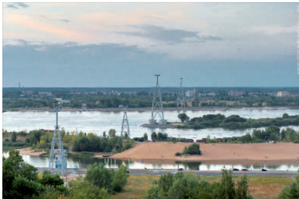
▲ RIESIGE STÜTZEN, VON DENEN EINIGE 82 M HOCH SIND, ERLAUBEN BEI NISCHNI NOWGOROD EINE ÜBERQUERUNG DER WOLGA IN DER LUFT. POMA ZEICHNET VERANTWORTLICH FÜR DIE ERSTE SEILBAHN RUSSLANDS IM STÄDTISCHEN NAHVERKEHR
