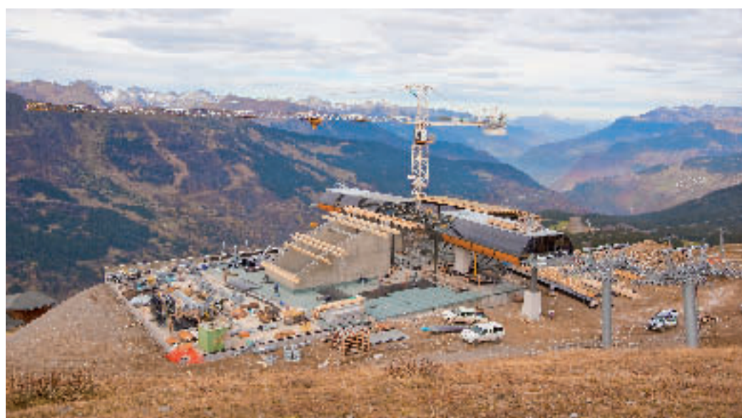
▲ MÉRIBEL: DIE IN BAU BEFINDLICHE STATION DER MULTIX 8-KABINENBAHN DES SAULIRE EXPRESS IN LUFTIGER HÖHE
