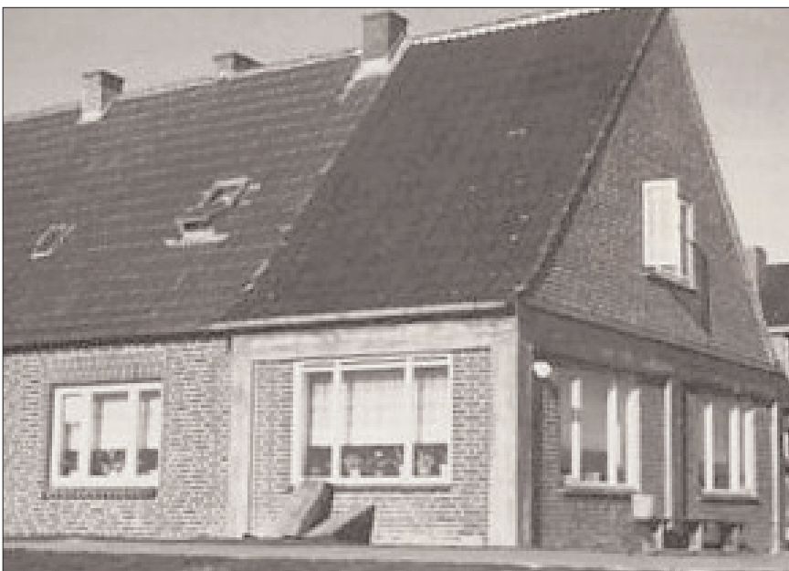
Sollte das übrige Gebäude bei einer Sturmflut auch völlig zerstört werden, so bietet der deutlich erkennbare Fluchraum mit seinen 4 m tief in den Warftboden reichenden Pfeilern große Sicherheit.
