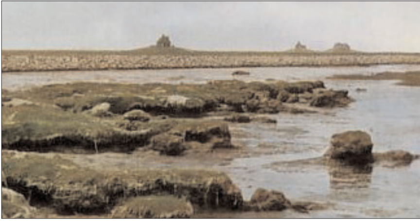
Hallig Nordstrandischmoor mit der letzten Abbruchkante. Die Steinböschung als Ufersicherung ist deutlich zu erkennen. (Aufn. 1968)
