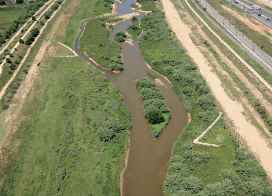
En el tram II, riu avall de Sant Boi, s'han introduït uns deflectors a la llera del riu que contribueixen a recuperar un curs més natural.
