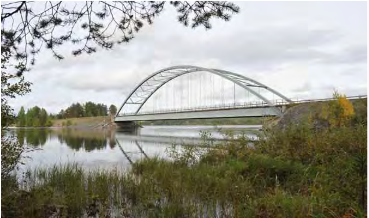
Sidovy av bågspannet och de fyllnadsbankar som leder fram till broläget. Bankarna avslutas med koner av ordnad sten som även tjänar som erosionsskydd vid landfästena.
