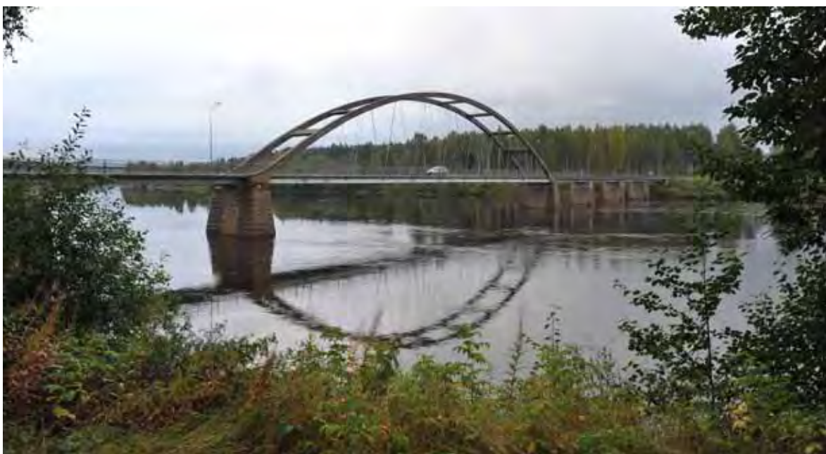
Ovan: Bron är asymmetrisk med fyra respektive två sidospann av stål balkstyp. Balkarna är kontinuerliga över flera stöd och är sammanfogade på ett tidstypiskt sätt med nitförband (motstående sida nederst).
