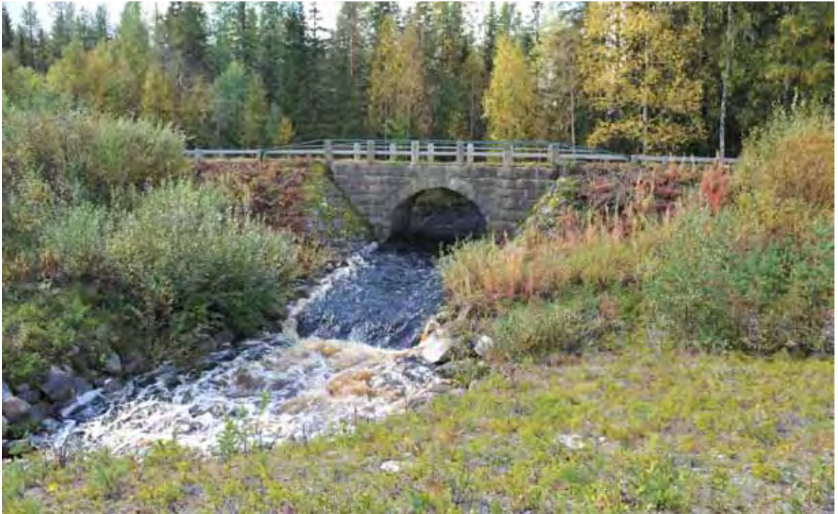
Vackert belägen stenvälvbro med liten fors nedströms bron. Korta fyllnadsbankar avslutas med välgjorda stenkoner som ansluter väl till bronns form och material.
