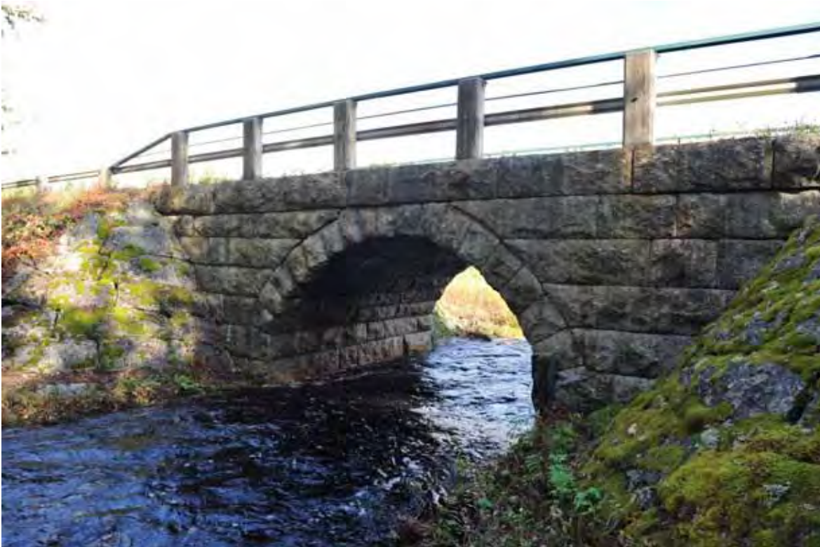
Stenarbetet i bron är välgjort med kvaderhuggen sten i jämna skift och ett tydligt markerat valv. Betongstolparna och räcket har tillkommit senare och ersatte sannolikt ett betydligt enklare smidesräcke.
