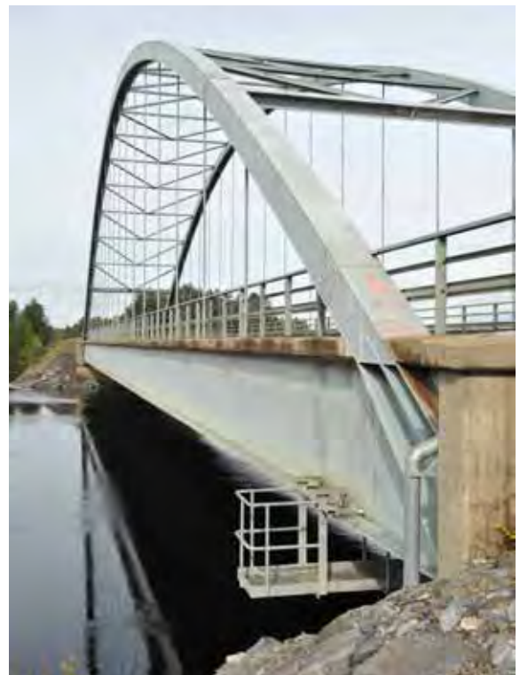
Pilformade övre vindförband bidrar effektivt till bronns karaktär.
