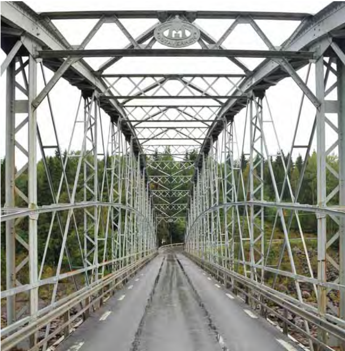
Ett högrest och intrikat fackverk som kröns av den karaktäristiska tillverkningsskylten från AB Götaverken i Göteborg – en av landets stora och betydande brotillverkare.
