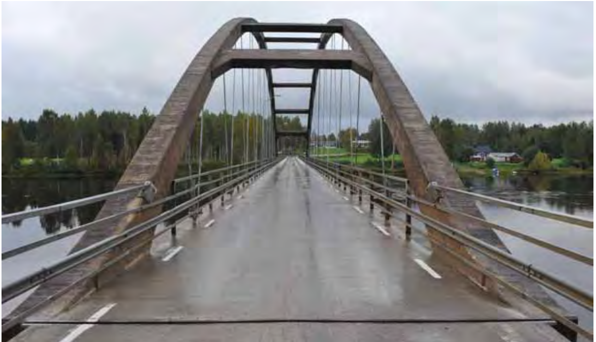
Bågspannet är totalt dominerande och på nära håll syns de snedställda hängstagen tydligt.
