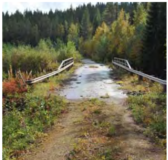
Bron ligger på en indragen vägsträcka som idag fungerar som inofficiell rastplats och skogsbilväg. Ett visst underhåll är önskvärt om inte vegetationen helt ska ta över konstruktionen.
