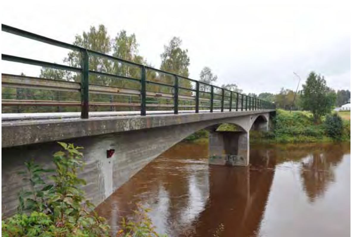
Två elegant votade balkspann med tidstypiskt materialoptimerat bärverk.
