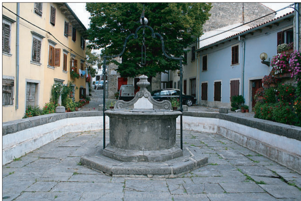
Pinguente, la cisterna maggiore, oggetto di un restauro previsto nel piano 2007
