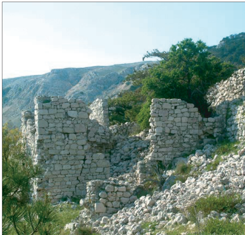
La Regione Veneto contribuirà al restauro della cinta muraria di Veglia
