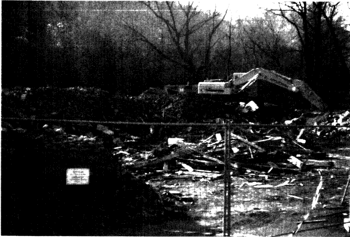
Bild 26: Abbruch der Obermühle - Frühjahr 2002-11-17
