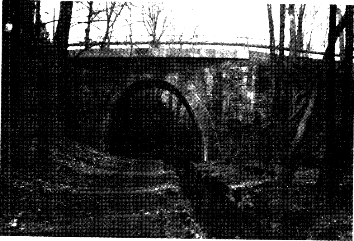
Bild 12: Mühlgraben der Walzen - Mühle am Fußweg des Rabenauer Grundes
