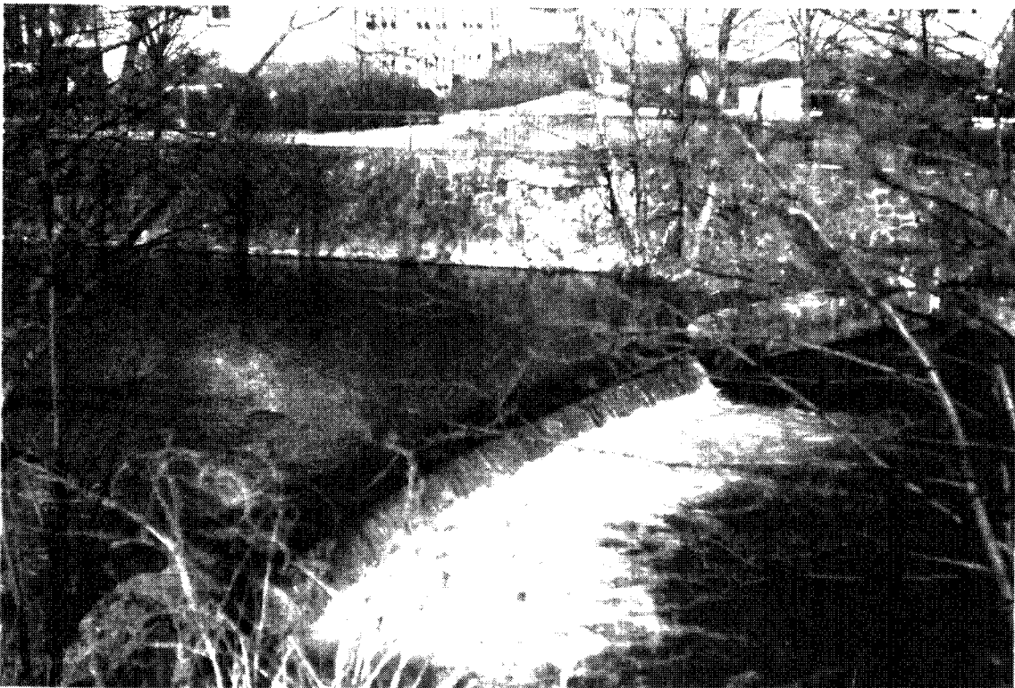
Bild 25: ehemalige Staustufe, Abgang Mühlgraben Rote Mühle
