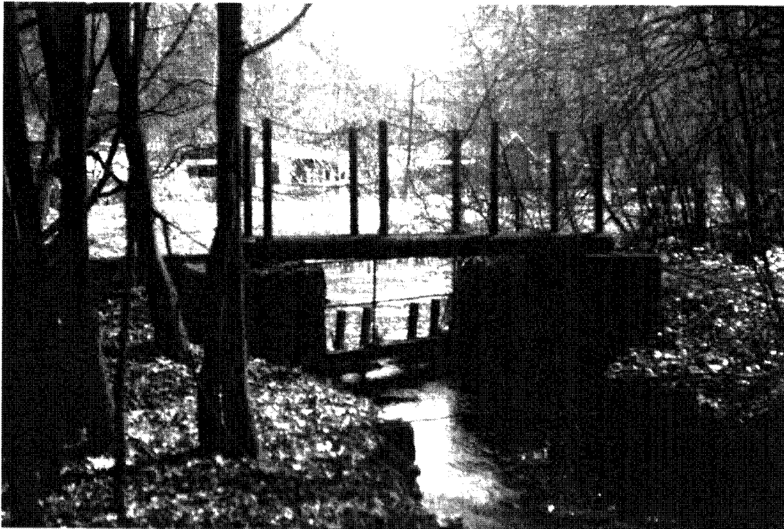
Bild 11: Rechen und Schieber Mühlgraben Walzen - Mühle
