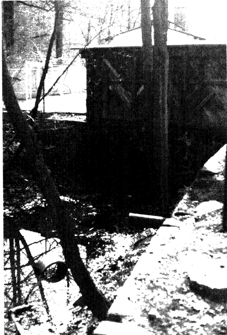
Bild 35: Auslauf Wassergraben Feilenfabrik
