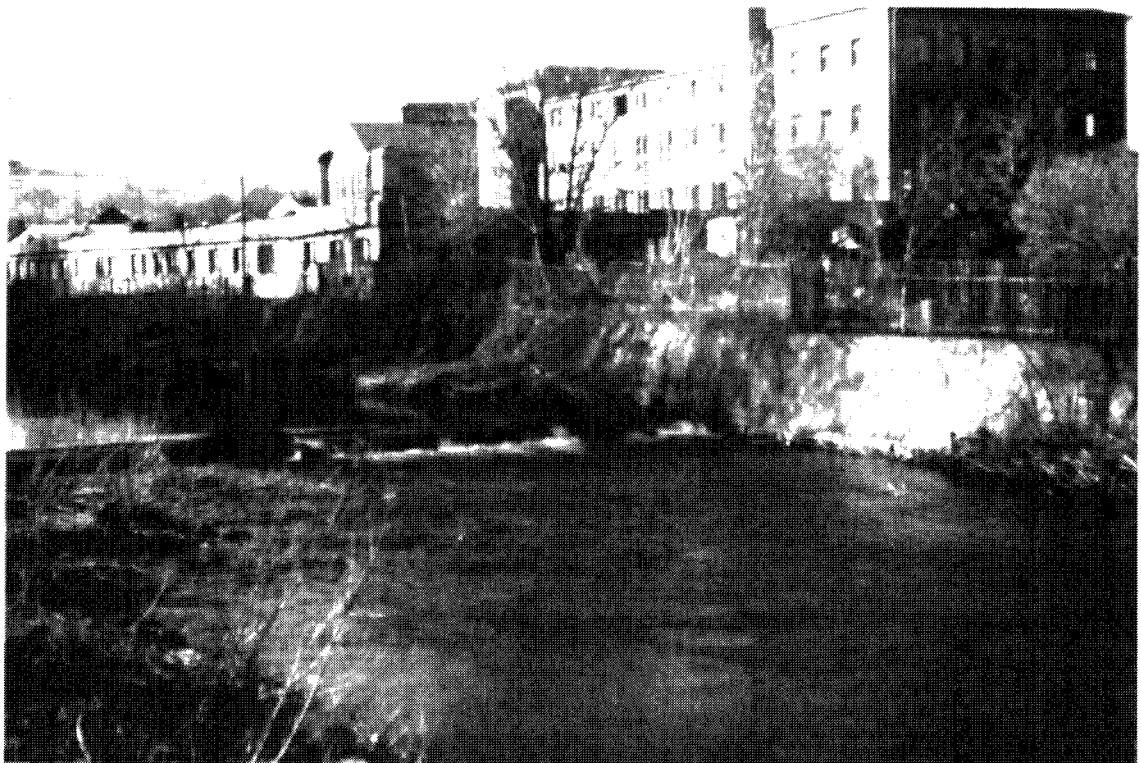
Bild 38 Staustufe der Überpumpenanlage für Brauchwasser Gussstahl - Werke / Fabrik 93 Wismut
