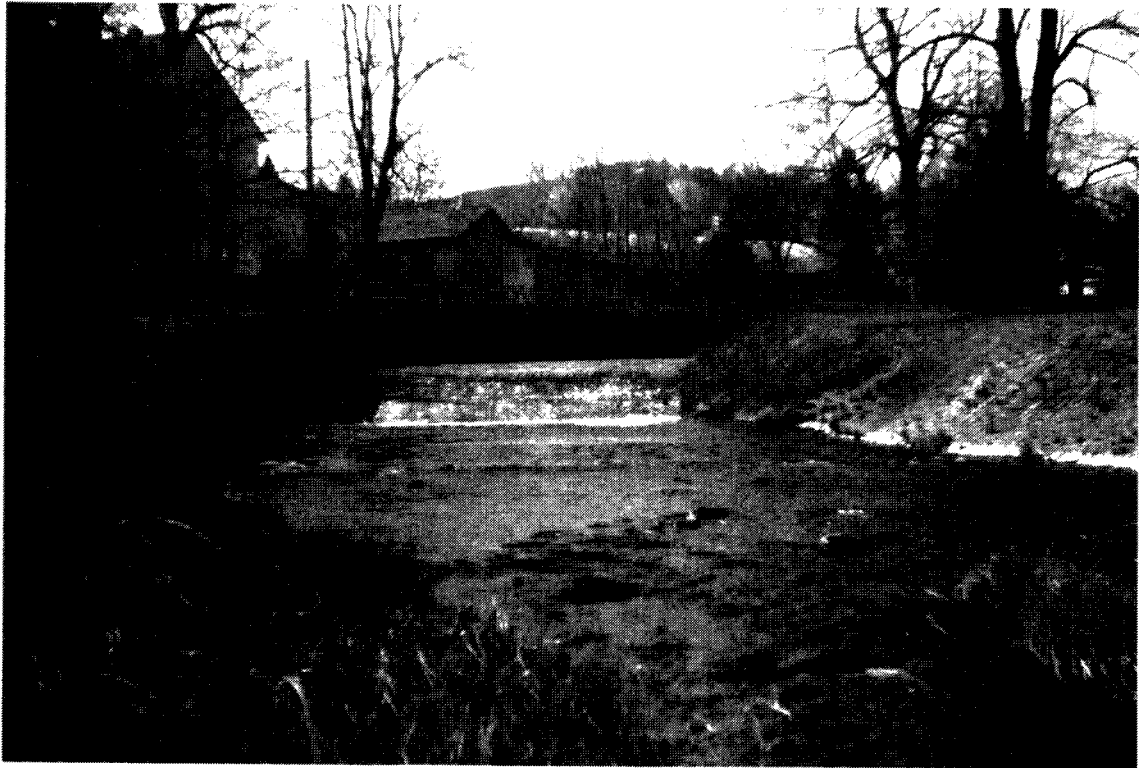
Bild 18: Staustufe Abgang Mühlgraben Mehnert-Mühle
