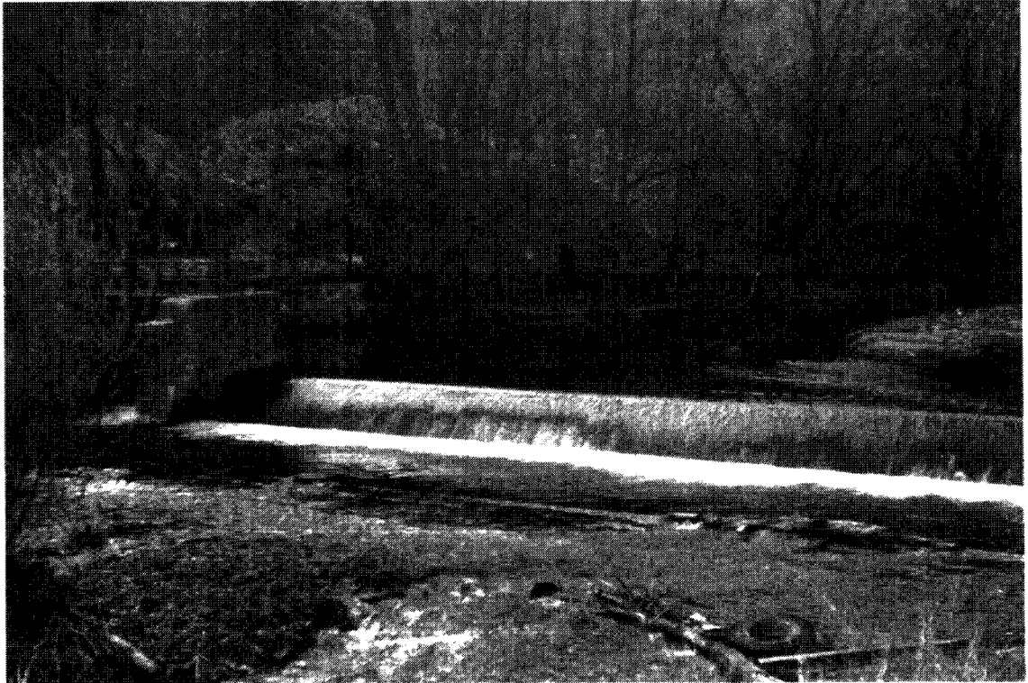
Bild 32: Staufstufe, Abgang des Wassergrabens zur Papierfabrik Hainsberg
