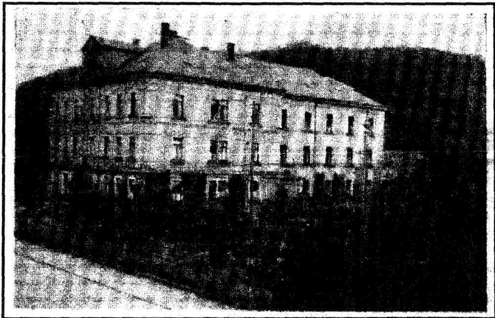
Abb. 4: Ehemaliges Produktionsgebäude der Mehnert-Mühle
