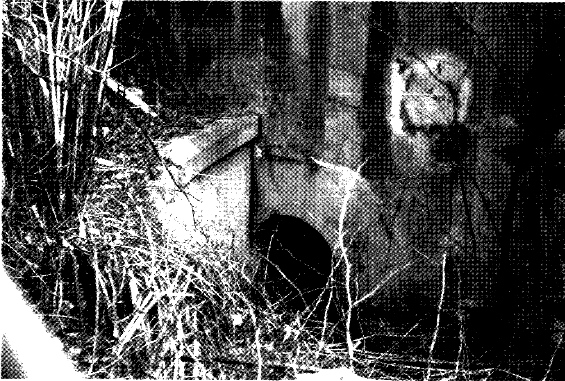
Bild 7: Auslauf Mühlgraben Backofenmühle - Unterführung Bahntrasse
