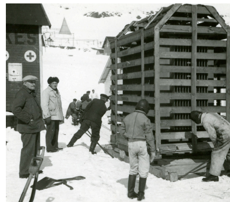
Her har en generator ankommet Kongsfjord og skal transporteres til kraftverket. Bildet er tatt på 1940-tallet (foto: Varanger Krafts arkiv).
