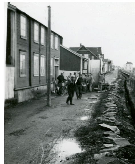
Havnegata i Vadsø. Kabelstrekkingen ble gjort for hånd de første årene (foto: Varanger Krafts arkiv).
