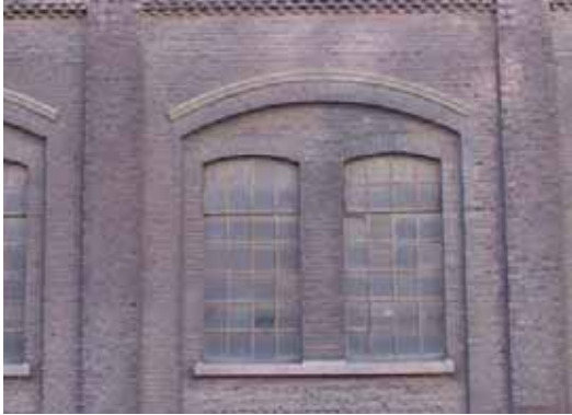
Gietijzeren vensters, waarbij bovenlicht uit smeedijzer bestaat.
