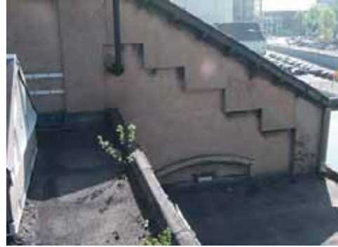
De originele geelroze kleur aan de westelijke gevel.
