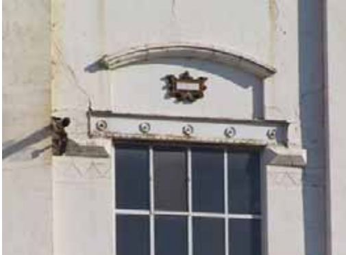
Decoratief programma boven de rechthoekige vensters. Met name de stalen latei is bijzonder.
