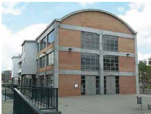
De Wiebengahal te Maastricht. Ondanks het bijna gelijktijdig ontstaan van beide gebouwen (Wiebengahal in 1912) is de constructie veel zwaarder. (linkerfoto: www.paulvroomen.nl ; rechterfoto: Kim Zwarts, www.nai.nl )
