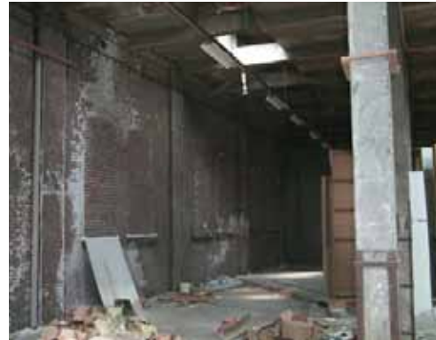
Bouwsporen van de vroegere buitengevel van het magazijn.
