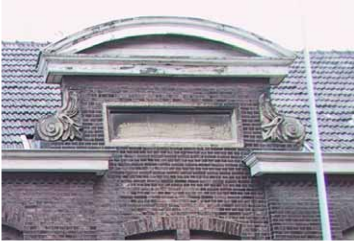
Het gebogen timpaan boven de entree.
