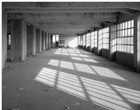
De Wiebengahal te Maastricht. Ondanks het bijna gelijktijdig ontstaan van beide gebouwen (Wiebengahal in 1912) is de constructie veel zwaarder. (linkerfoto: www.paulvroomen.nl ; rechterfoto: Kim Zwarts, www.nai.nl )
