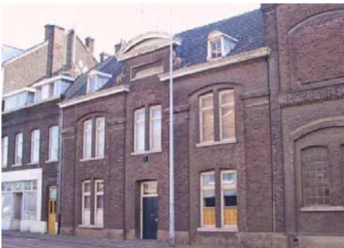
De voorgevel van de oude remise.
