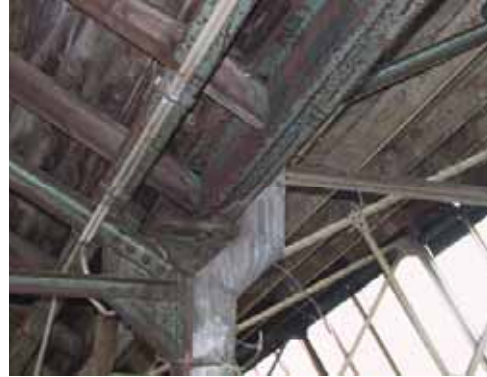
Detail van de geklonken stalen sheddakconstructie.
