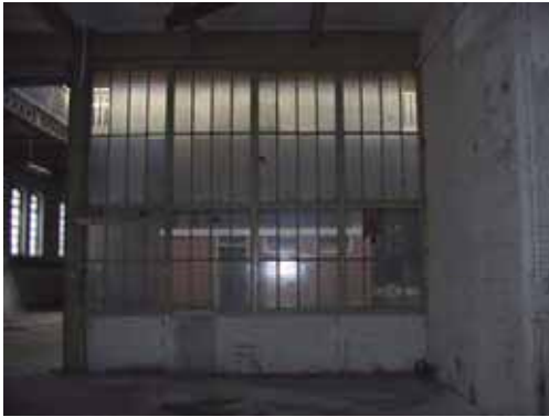
De glaswand met een zeer bijzondere roedeverbinding.
