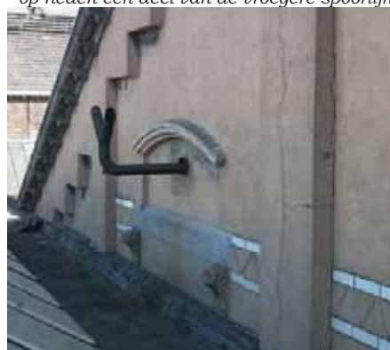
De originele polychromie op de westgevel.
