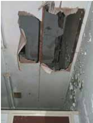
Verborgen achter het verlaagd plafond in het sanitair, gaan de originele dakkoepels schuil.
