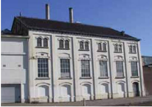
De voorgevel van de machinehal bestaat, ondanks de maar twee aanwezige verdiepingen uit een drieledige indeling
