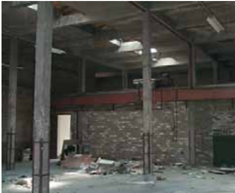
De uitermate ranke betonconstructie van de kistenmakerij.
