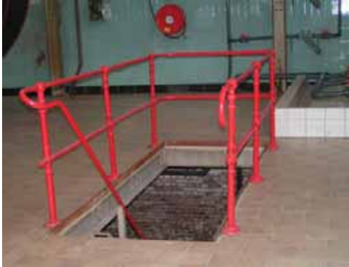
Een van de twee originele trappen die naar de kelder (souterrain) leidt.
