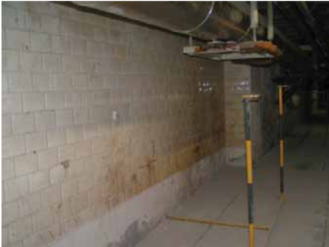
De wanden in de tunnel zijn gedeeltelijk voorzien van keramische tegels.
