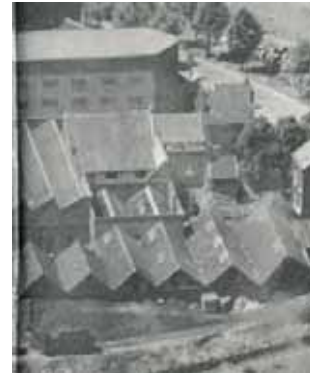
Detail van luchtfoto uit 1950. De stalen en het volume op de binnenhof zijn deels afgebroken; de achterbouw is ingemetseld.
