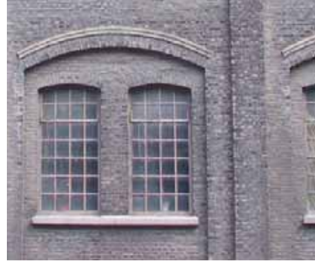
Onder de vijf meest noordelijke rondbogen zijn de gietijzeren vensters door stalen varianten vervangen.
