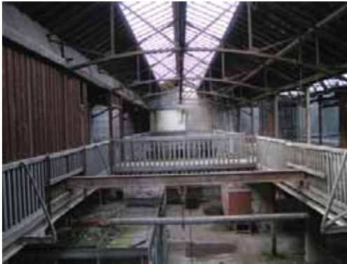
De spantenconstructie in de vide.
