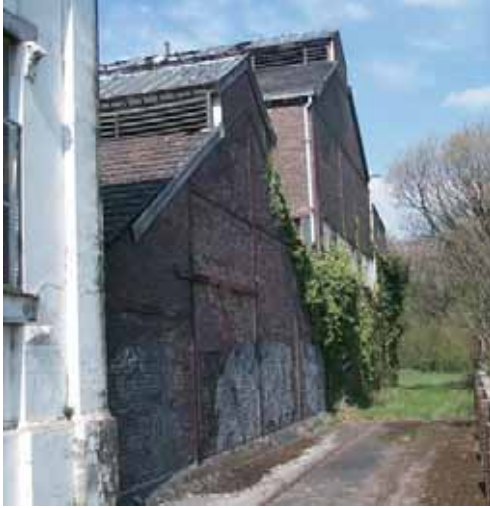
De twee ketelhuizen.
