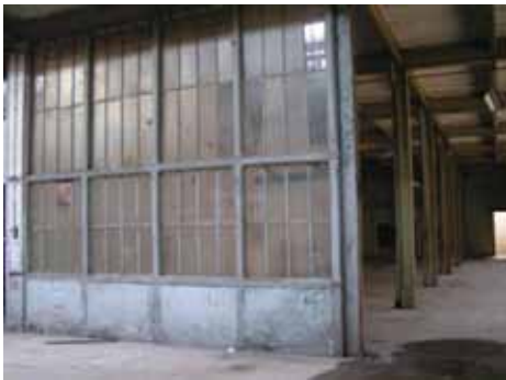
De glaswand met de koude stalen roedeconstructie. In de ruimte erachter ziet men de betonnen vloer op de gietijzeren staanders en liggers.
