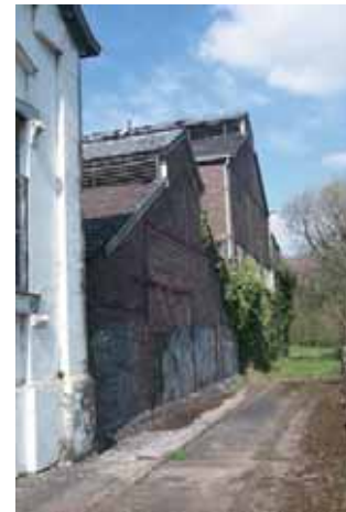
Restant van de vroegere verbindingslijn met het spoor Maastricht-Hasselt, ten oosten van elektrische centrale.
