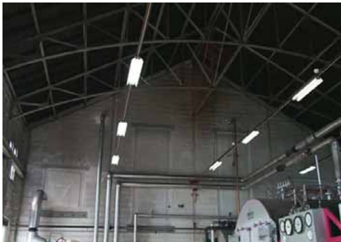
Interieur van de machinehal met een soortgelijke spantenconstructie als magazijn. Rechtsboven decoratief stalen element. Rechtsonder decoratieve elementen boven de vensterpartijen
