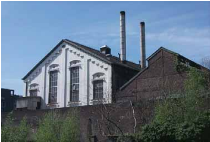
De kopwand van de centrale aan de zijde van de Zuid-Willemsvaart met het daarachter gelegen ketelhuis, waarvan de nok is 'opgetild' ten behoeve van de ventilatie
