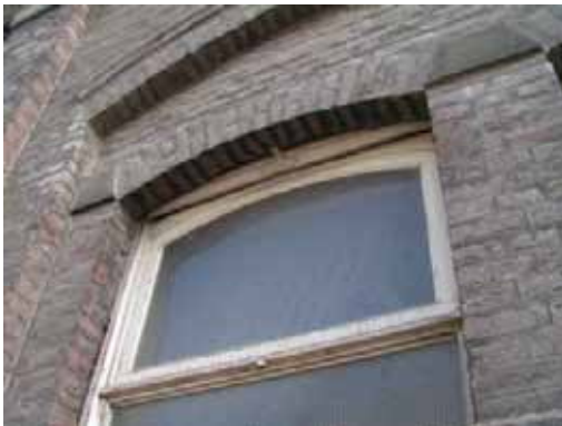
Rondboogvenster met originele ramen (zonder middenlijst) en met originele rolluik.
