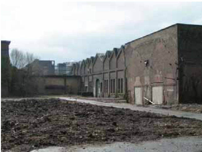
Locatie van de vroegere zes hallen. Op de bakstenen ommuring van de achterbouw van de remise zijn nog bouwsporen van de verdwenen volumes zichtbaar.
