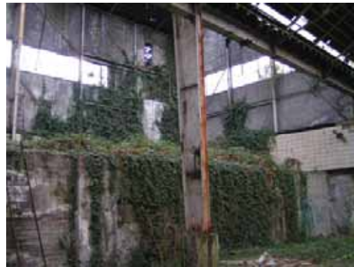
Het overwoekerde interieur van het ketelhuis uit 1933.
