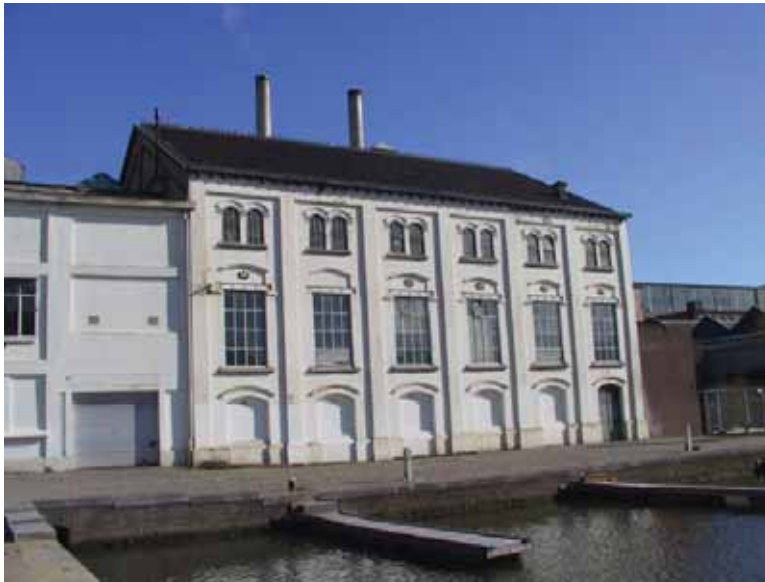
De machinehal van de elektriciteitscentrale
