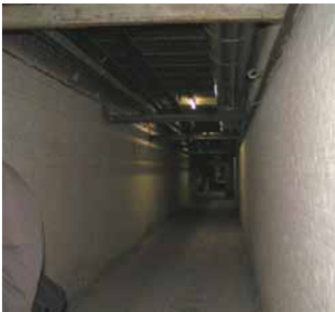
De tunnel onder de Boschstraat.
