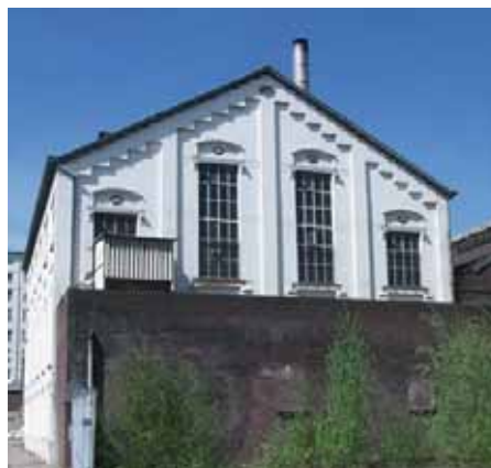
De oostgevel. De verhoging voor de gevel huisvest tot op heden een deel van de vroegere spoorlijn.
