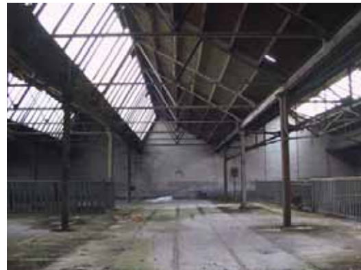
De lichte sheddakconstructie op de eerste verdieping.
