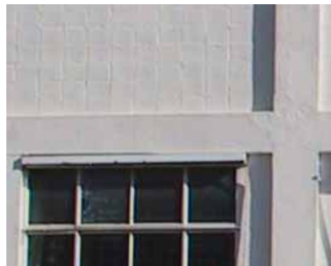
In de muurvlakken tussen de betonconstructie zijn de bouwstenen zonder metselverband op elkaar geplaatst.
