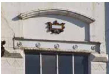
Eén van de lateien met boogtrommel en cartouche boven de ramen van de Elektriciteitscentrale.
