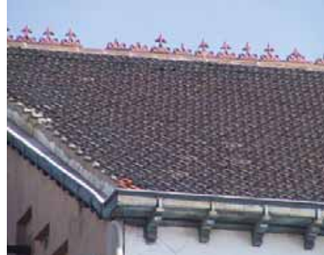
Het dak van de machinehal is verfraaid met keramische nokruiters, geprofileerde houten gootklossen en decoratieve stalen beugels.
