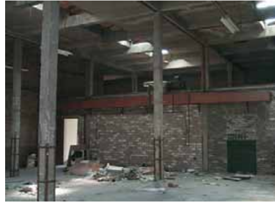
Het Hennebique-systeem in de kistenmakerij. De kolommen zijn uiterst slank.
