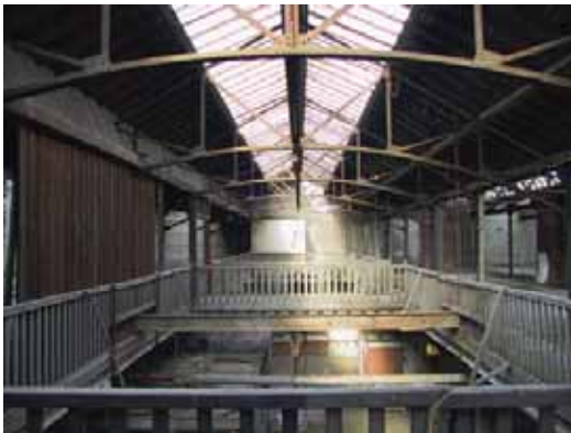
De spantenconstructie en balustrades in de centrale travee.
