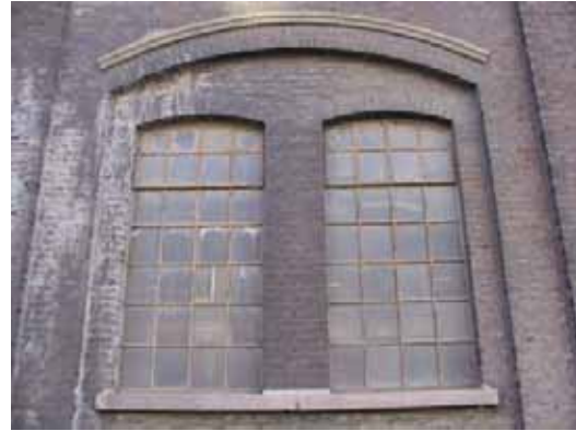
Originele gietijzeren vensters.
