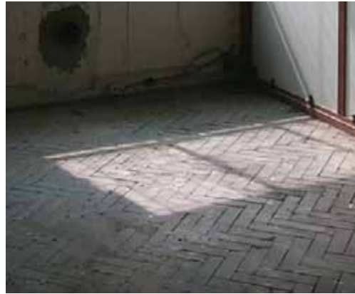
Parket in visgraatmotief. Deze vloer ligt in de meeste ruimten van het kantoor.
