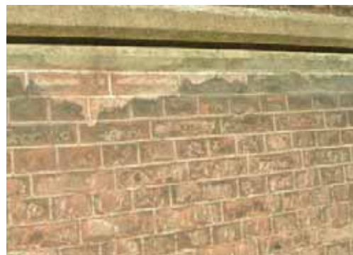
Metselwerk in kruisverband waarbij de oneffenheden in de baksteen zijn opgevuld.
