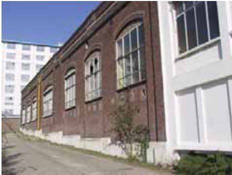
Zuidelijke gevel van het kantoorgebouw
