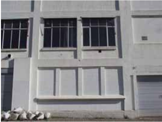
De betonconstructie is duidelijk zichtbaar. De muurvlakken zijn opgevuld met op elkaar gestapelde bouwstenen.
