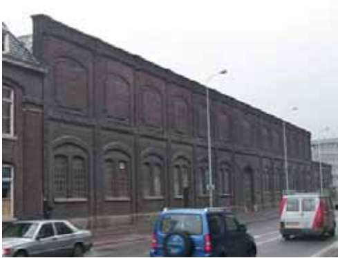
De sheddaken zijn aan de Boschstraat weggewerkt achter een horizontale gevel.
