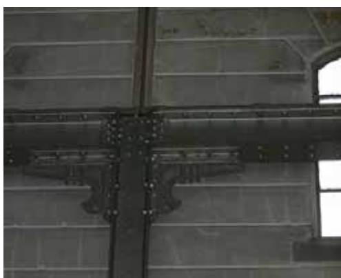
Bijzondere geklonken verbinding
