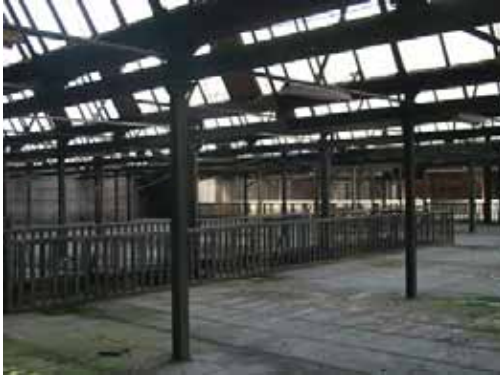
Door de sheddakenconstructie en het ontbreken van muren is de eerste verdieping zeer 'open'.
