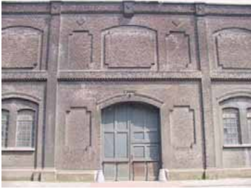
Entreepartij in centrale travee van het magazijn
