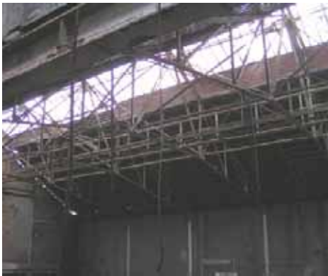
Polonceau-spanten in het ketelhuis uit 1910
