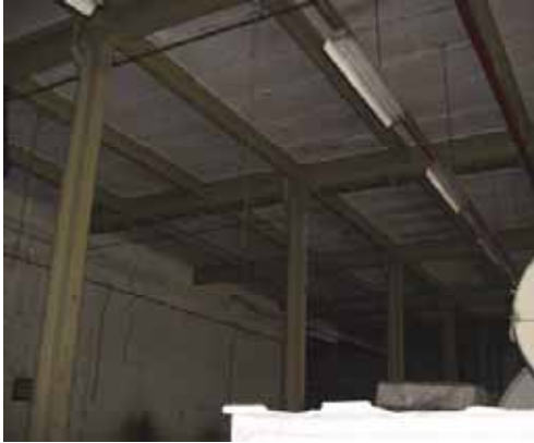
De geklonken staalconstructie en betonnen plafond. De kolommen bestaan uit I-profielen.
