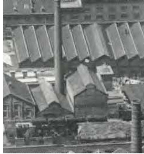
Op deze luchtfoto uit 1950 is de nu verdwenen schoorsteen van het ketelhuis uit 1910 nog aanwezig.
