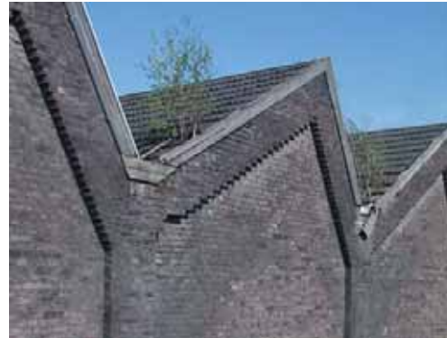
Aan de achterzijde volgt de gevel de vorm van de sheddaken.
