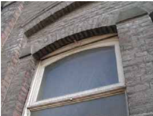
Rondboogvenster met originele in de muur geplaatste kozijn en rolluik.
