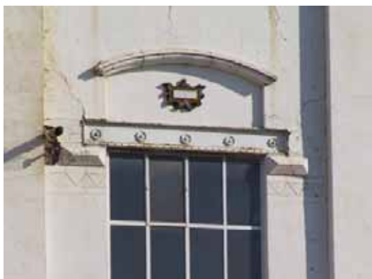
Ornamentering rondom de vensters op de eerste verdieping
