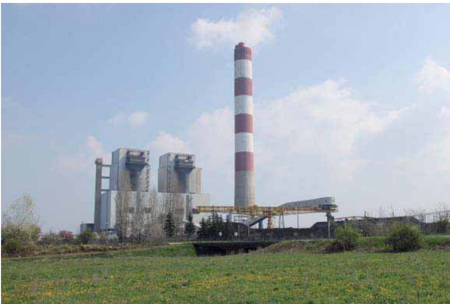
У капиталном ремонту Б-2 важни су и радови на турбогенераторском постројењу
