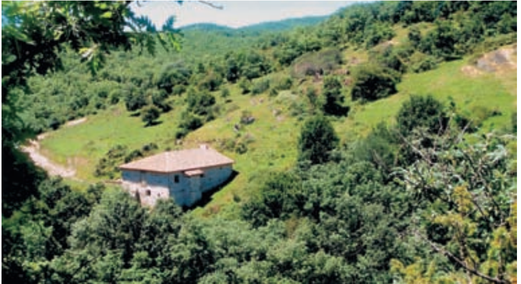
La Casa del Solar de Tejada en Cameros
