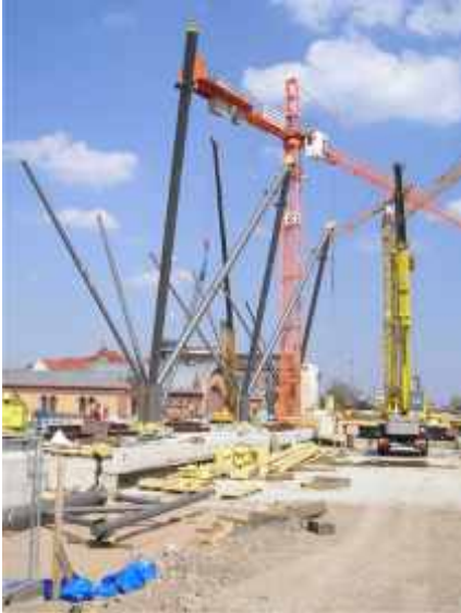
Montage der V-Stützen
