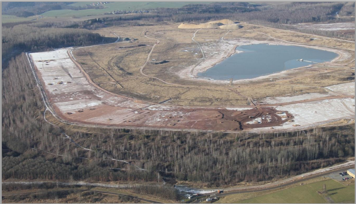
Auflastschüttung am Süd- und Südostdamm der IAA Culmitzsch, Februar 2012, Foto: TLBA
