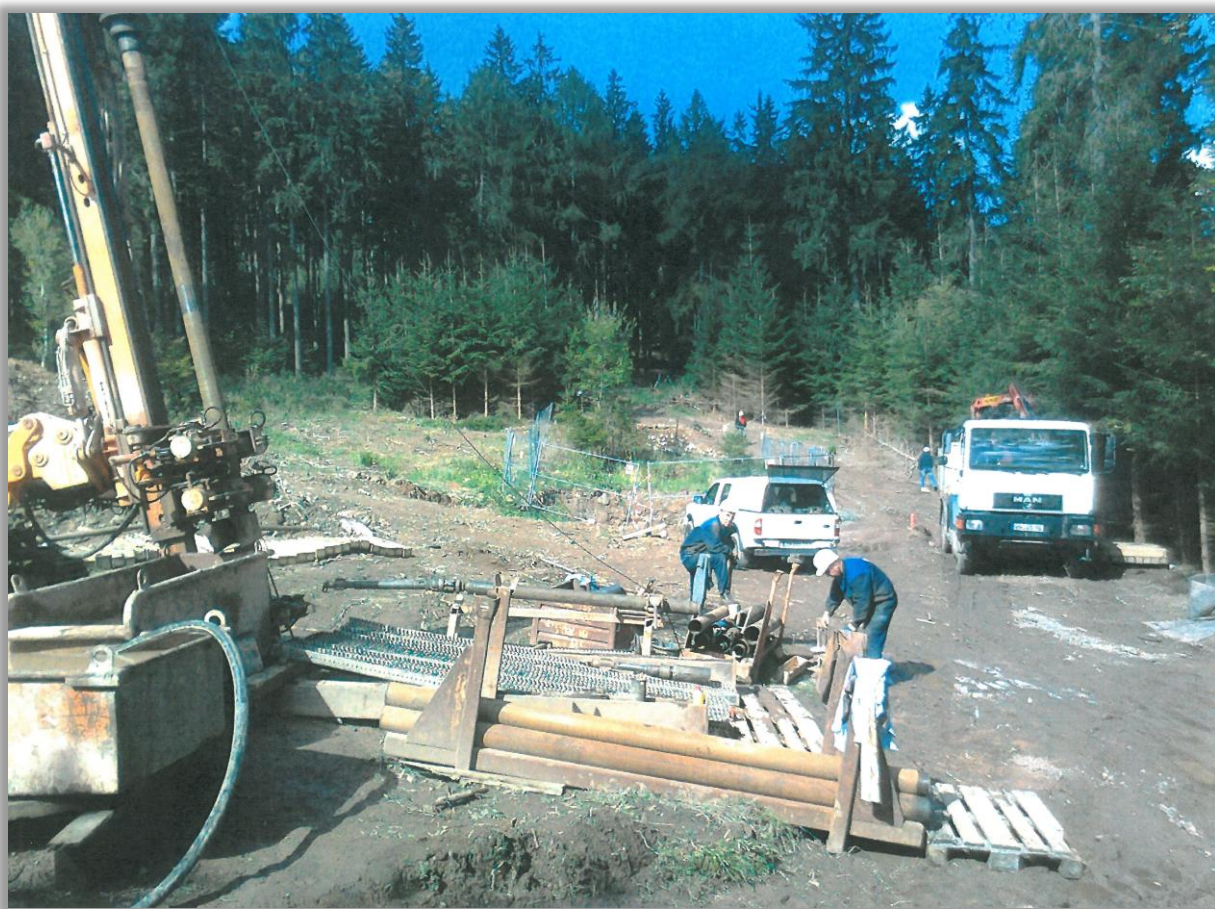
Bohrerkundung auf dem „Biankagang“ der Schwerspatgrube „Friedenstein“ bei Ruhla im Bereich gefallener Tagesbrüche 09 2012
