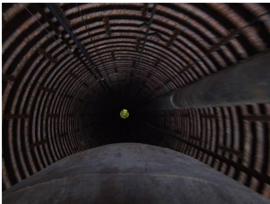
Blick in die Schachtröhre (Bereich Tübbingausbau)
