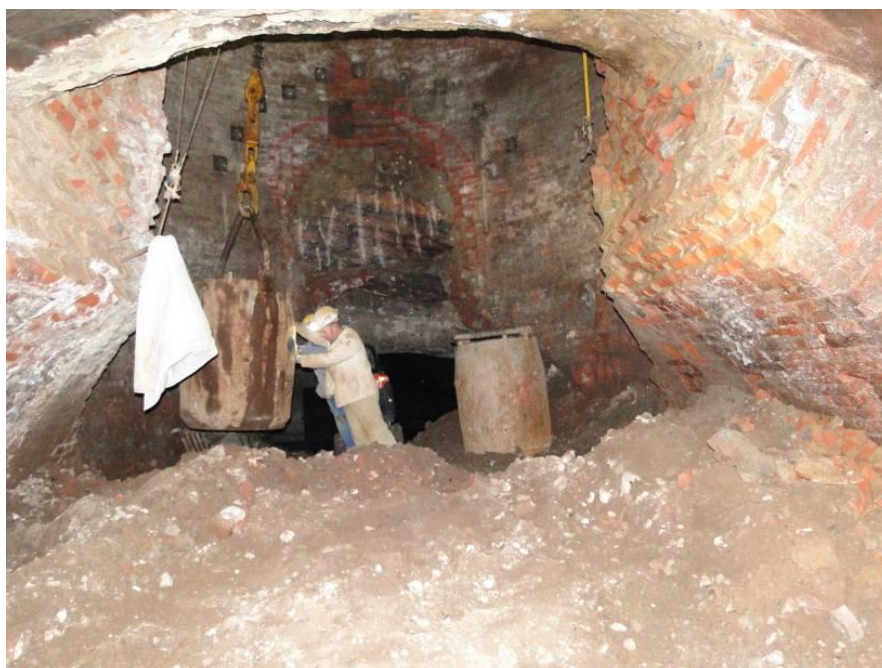
Beräumung Füllort 2. Sohle
