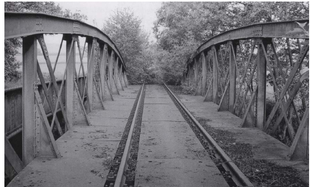
Abb. 2.04 Eisenbahnbrücke ehemalige Ohmtalbahn
