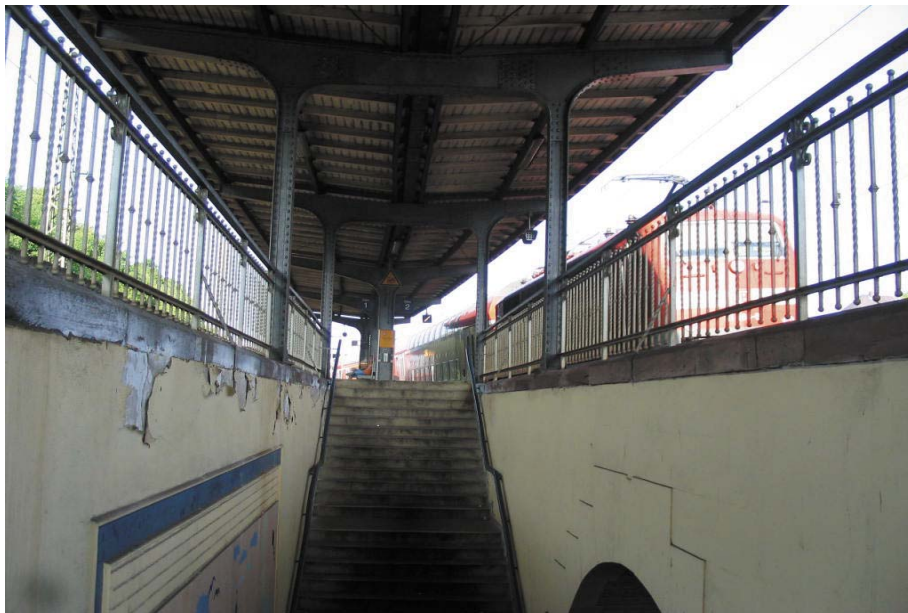
Abb. 2.15 Bahnhofstreppen zum Gleis
