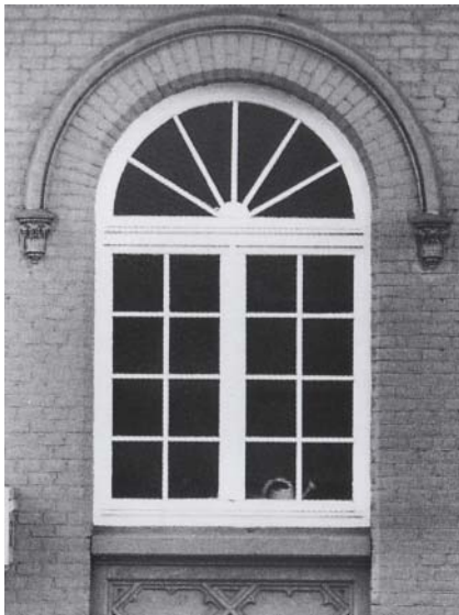
Abb. 2.07 Fensterdetail Bahnhof I
