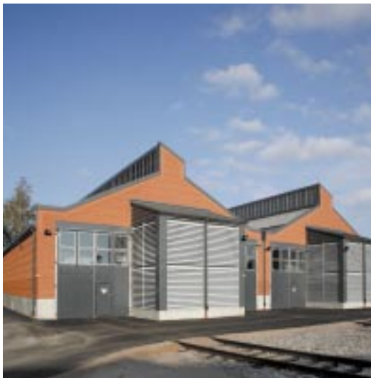
OMFORMARSTATION, MJÖLBY. BYGGHERRE: BANVERKET ÖSTRA BANREGIONEN.
